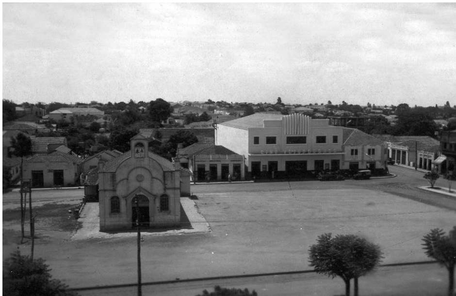
Praça Dr. Fernando Costa antes da demolição da primeira capela e projeto de paisagismo e infraestrutura. Década de 1940.
