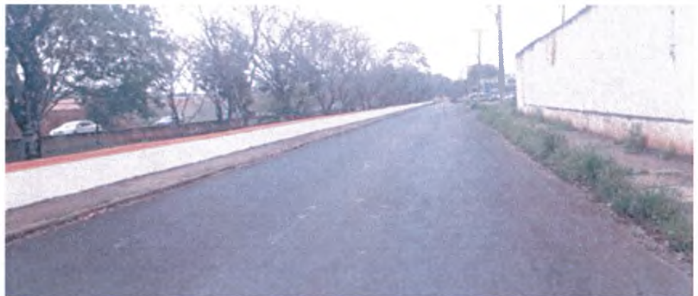
5. Localização: Avenida João Perissinotti em frente ao Ginásio de Esportes Antônio D' Ambrósio Cenário: Pintura de lombada em desacordo com o padrão exigido
