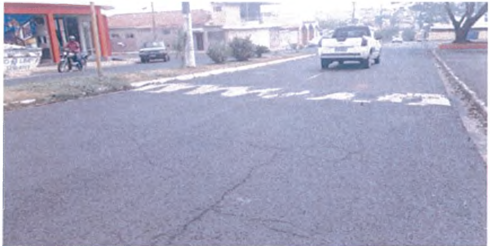
5. Localização: Avenida João Perissinotti em frente ao Ginásio de Esportes Antônio D' Ambrósio Cenário: Pintura de lombada em desacordo com o padrão exigido
