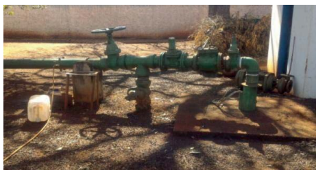
Foto 3.12 – Poço Estação Central
