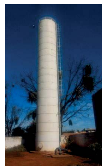
Foto 3.32 – Reservatório Antônio Garcia Silveira
