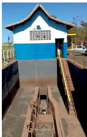
Foto 3.46 – EEE Final – Entrada do Esgoto
