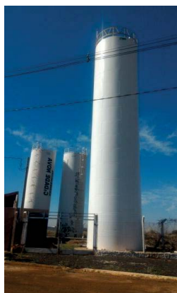
Foto 3.27 – Reservatórios Cidade Nova – R1, R2 e R3
