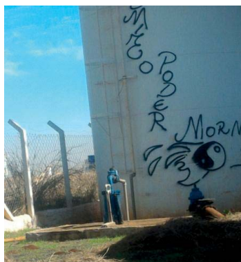
Foto 3.14 – Poço Cidade Nova 1
