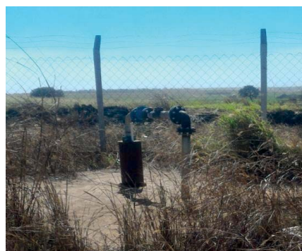
Foto 3.13 – Poço Cidade Nova 2
