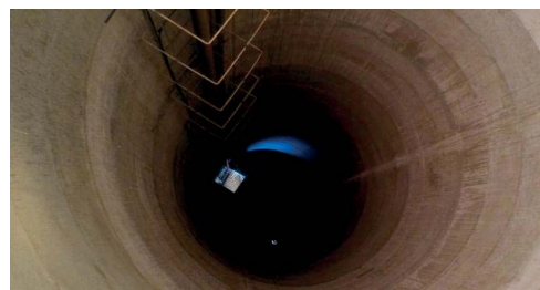
Foto 3.43 – Interior do reservatório
