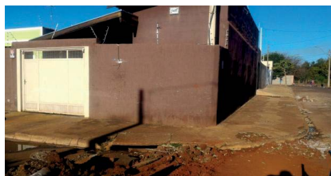
Foto 3.56 – Bueiro localizado na Rua México
