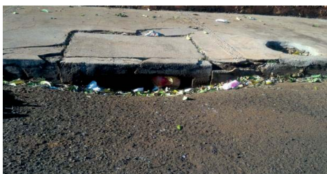
Foto 3.55 – Bueiro localizado na Rua José França
