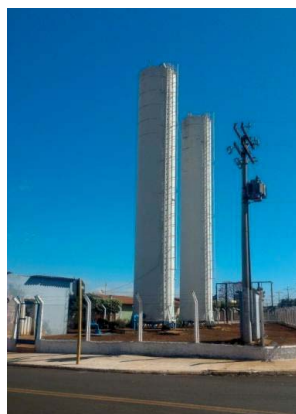
Foto 3.28 – Reservatórios Antônio Vicari – R1 e R2
