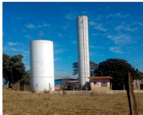
Foto 3.36 – Reservatórios Deocleciano Malheiro – R1 e R2
