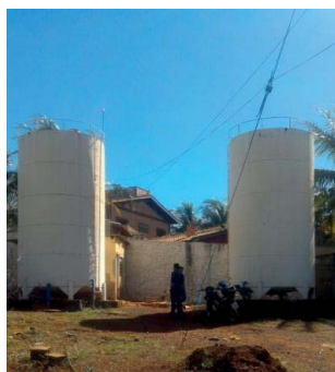
Foto 3.31 – Reservatórios Alto da Boa Vista – R1 e R2
