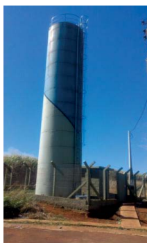
Foto 3.33 – Reservatório Monte Cristo – R1
