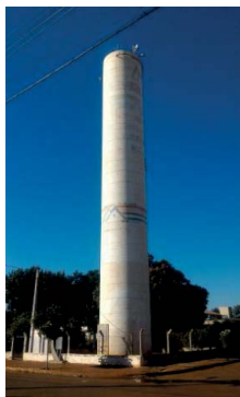
Foto 3.42 – Reservatório – Santo Inácio
