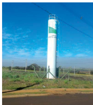
Foto 3.34 – Reservatório Monte Cristo – R2
