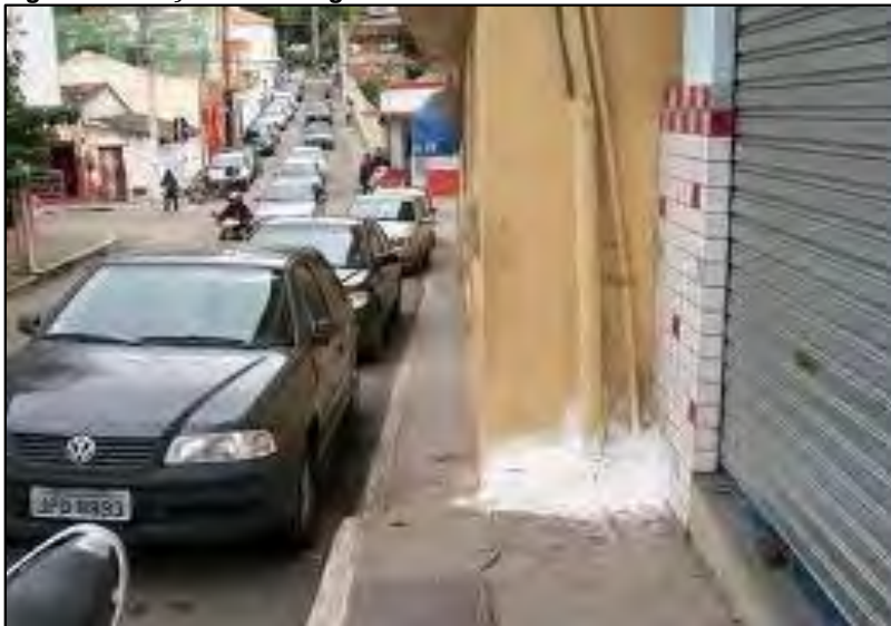
Figura 45: calçada sem largura mínima
