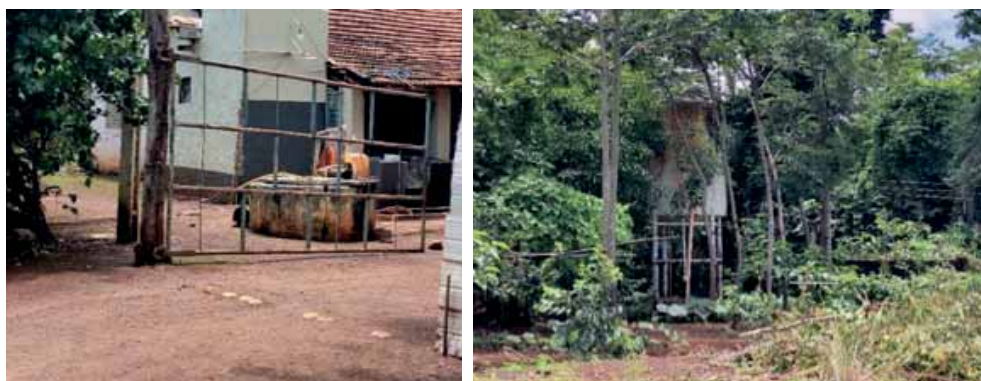
Figura 46 – Poço e reservatório
