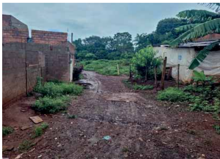
Figura 84 – Casas em área não regularizada sem atendimento de água e esgoto
