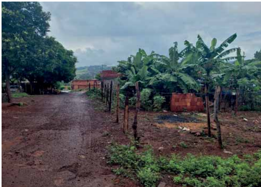
Figura 82 – Casas em área não regularizada sem atendimento de água e esgoto
