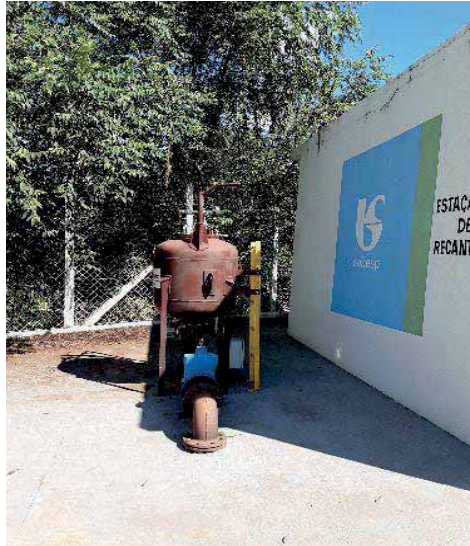
Figura 54 - EEE Recanto dos Pinheiros – Poço pulmão
