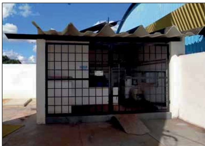
Figura 33 - Casa de química do reservatório 06 - externa
