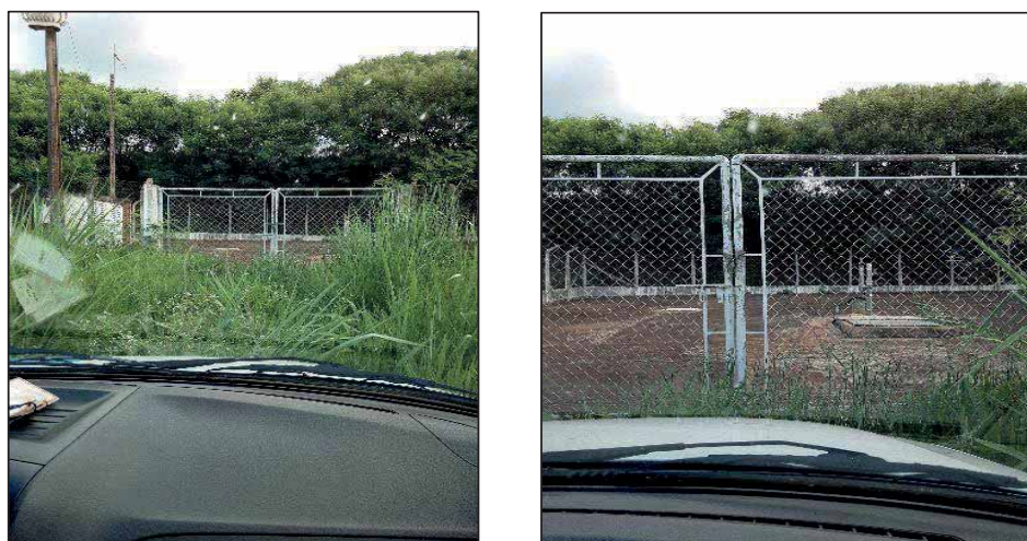
Figura 14 - Captação subterrânea através do Poço Redondo
