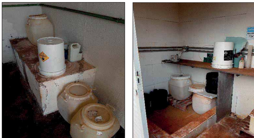
Figura 34 - Casa de química do reservatório 06 – interna
