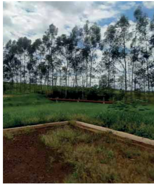
Figura 72 – Leito de secagem e lagoa anaeróbia
