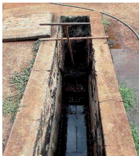
Figura 68 - EEE Hawai– Fachada e gradeamento
