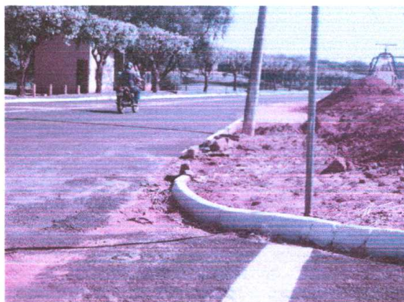
Foto 06 – Sarjetas danificadas.
