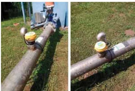
Ressalta-se que, esses medidores são interligados ao sistema de automação industrial e monitorados pelo Centro de Controle Operacional. Dessa forma, torna-se possível saber em tempo real a vazão de consumo de água de cada região. Na Figura 2, mostra-se uma tela do sistema supervisório de exemplo, na qual é possível ler a vazão de abastecimento, neste caso, da zona única do Pedro Nechar.
