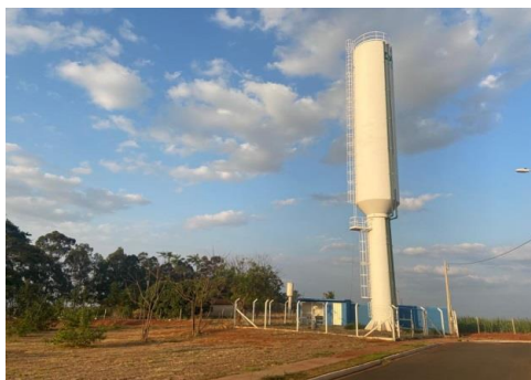
Figura 56: Vista Geral do Reservatório R-56
