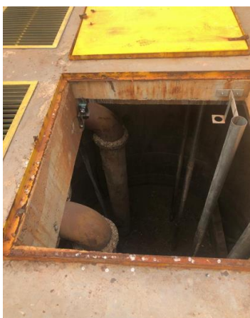
Figura 72: Vista superior do poço de sucção da EEE Final
