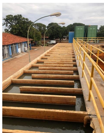
Figura 33: Chegada de água bruta na ETA-1
