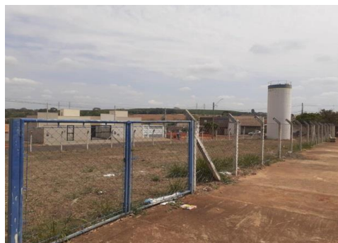
Figura 55: Vista Geral do Reservatório R-44
