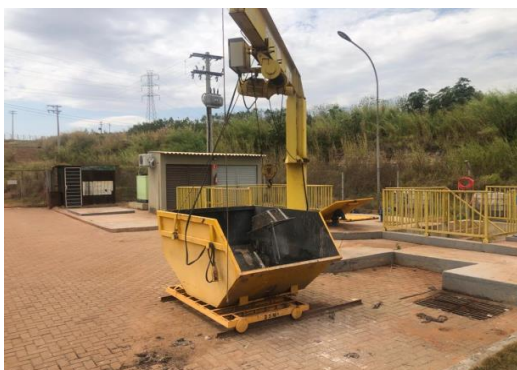
Figura 70: Vista geral da área da EEE Final
