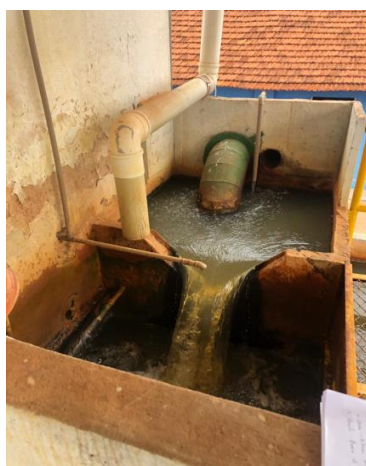
Figura 33: Chegada de água bruta na ETA-1
