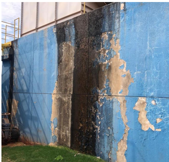
Figura 52: Situação atual do Reservatório Elevado da ETA-2
