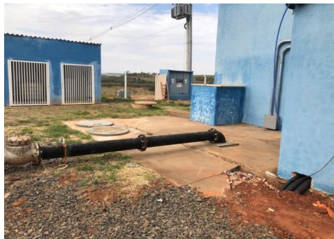
Figura 26: Entrada da tubulação de recalque do Poço Profundo PP-01 no poço de sucção da Estação Elevatória
