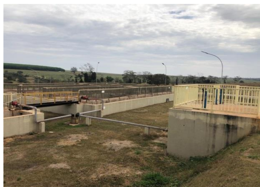
Figura 89: Vista geral dos Reatores Anaeróbios
