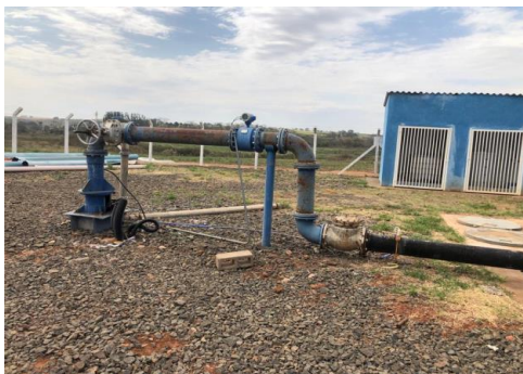
Figura 25: Vista do Poço Profundo PP-02
