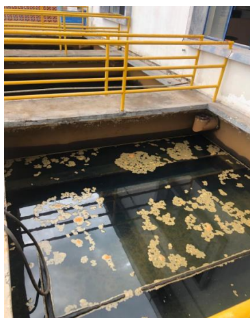
Figura 34: Detalhe dos Filtros da ETA-1
