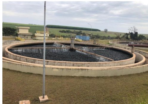
Figura 91: Filtro Biológico Anaeróbio
