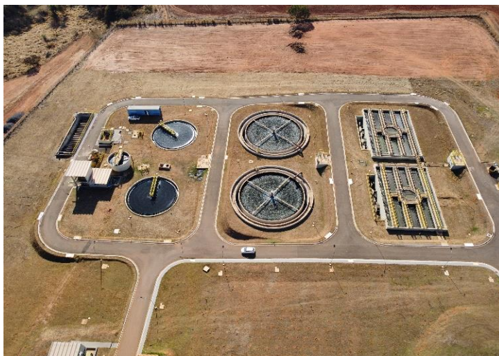
Figura 83: Vista geral da ETE Olhos D'Água
