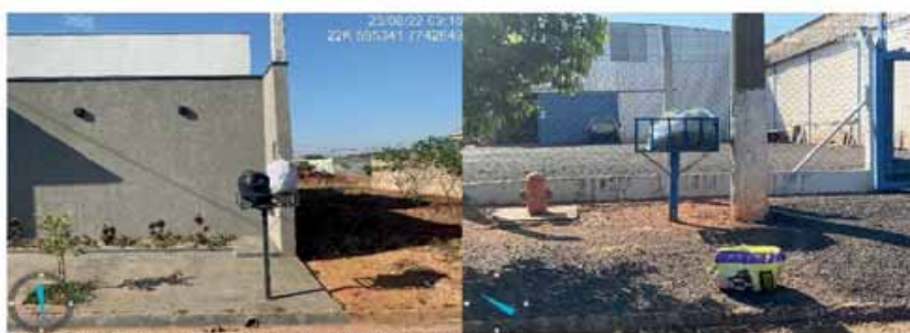
Figura 5 - Lixeiras instaladas em residências e comércio.
