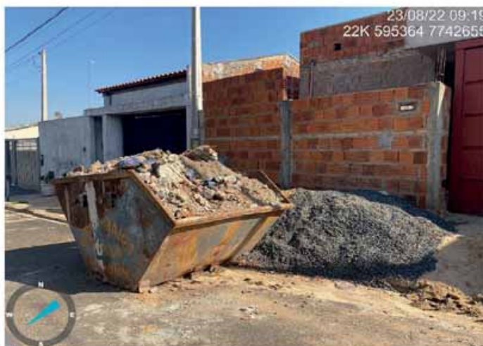
Figura 26 - Caçamba na frente de construção.
