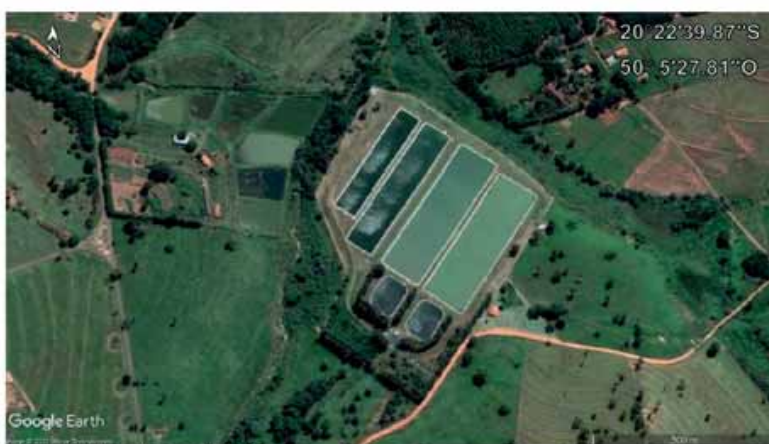
Figura 30 - Localização da ETE.
