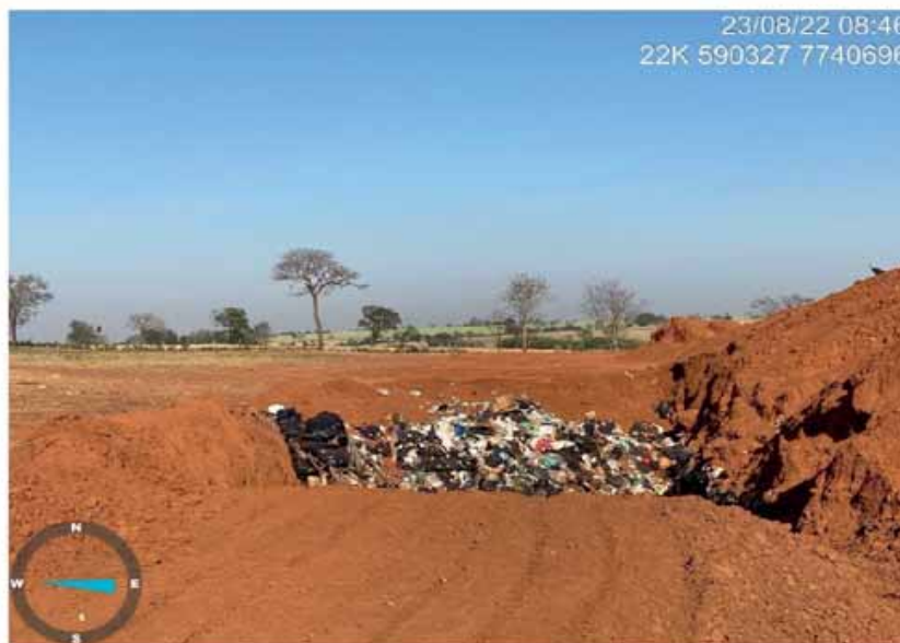
Figura 12 - Vala do aterro.
