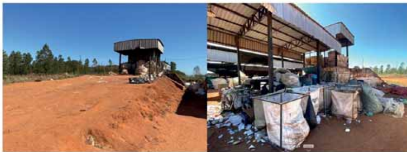
Figura 17 - Rampa de recepção dos RSDR.
