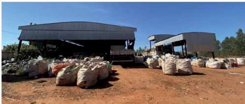
Figura 16 - Vista geral do centro de recebimento, triagem e acondicionamento dos RSDR.
