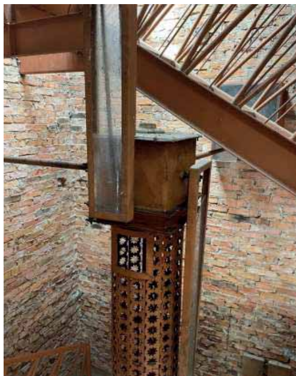
Mecanismo que movimenta os ponteiros, no centro do pavimento
