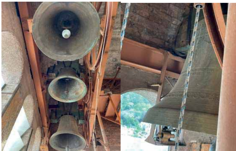
Os 3 sinos, herança do velho campanário da década de 1920, com os suportes metálicos, em substituição às vigas de madeira
