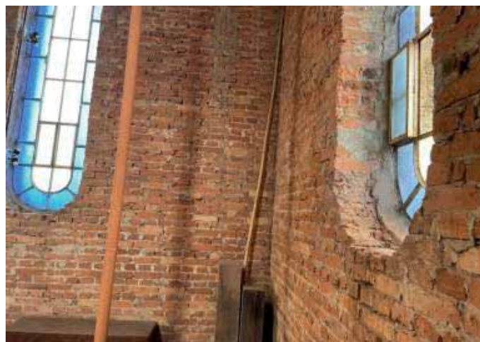
Visão transversal do mesmo pavimento
