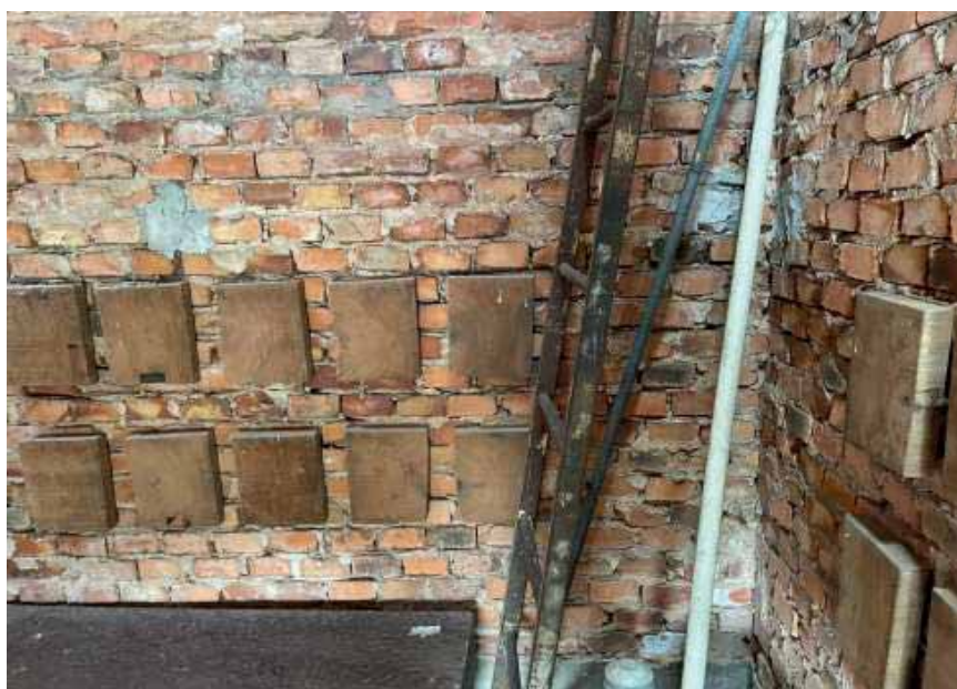
Mais detalhes de como ficavam as vigas de sustentação dos sinos em madeira, fixadas nas paredes que foram substituídos, pela segurança, por vergalhões metálicos
