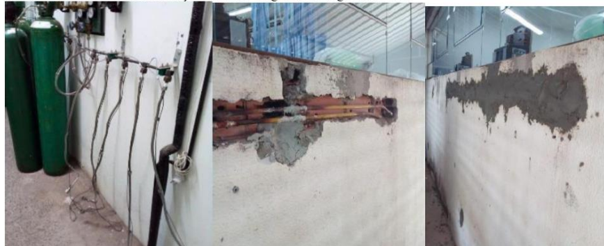
NOVEMBRO/2022: Manutenção da rede oxigênio da urgência covid
