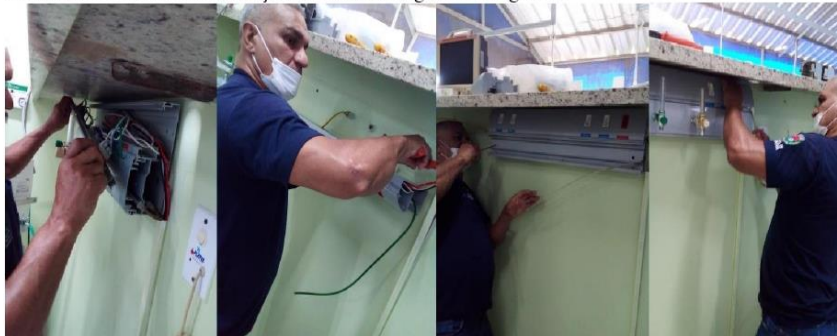
DEZEMBRO/2022: Manutenção na rede de oxigênio da urgência
