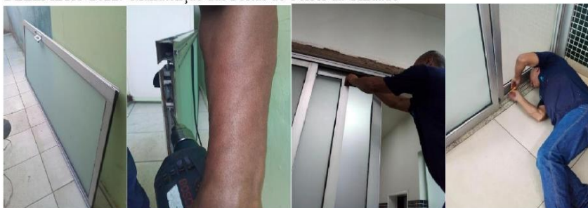
DEZEMBRO/2022: Manutenção das Portas de Correr da Unidade
