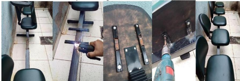
DEZEMBRO/2022: Manutenção Das Longarinas Setores Diversos
