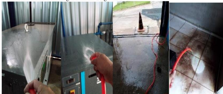
DEZEMBRO/2022: Lavagem da sala do gerador
