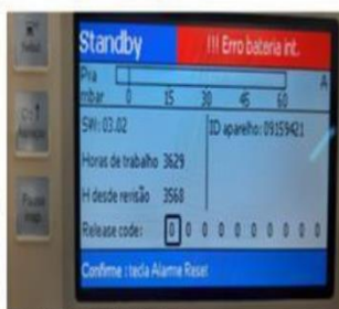
2- FALHA DE BATERIAS
