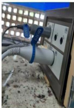
4-TROCA CABOS MONITORES
