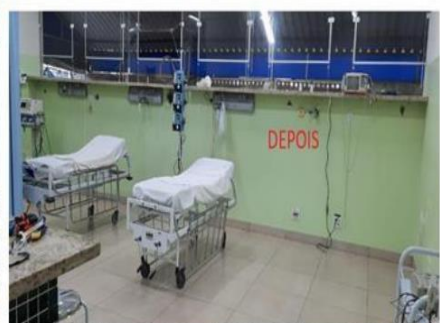
5-INSTALAÇÃO NOVAS REGUAS COM TOMADAS 2PTS OXIGENIO
