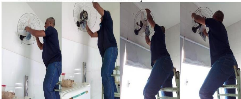
DEZEMBRO/2022: Manutenção ventilador da copa
