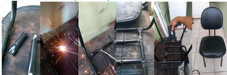
JULHO/2022: reforma/manutenção – Manutenção e soldagem de cadeiras e longarinas de diversos setores da unidade.
