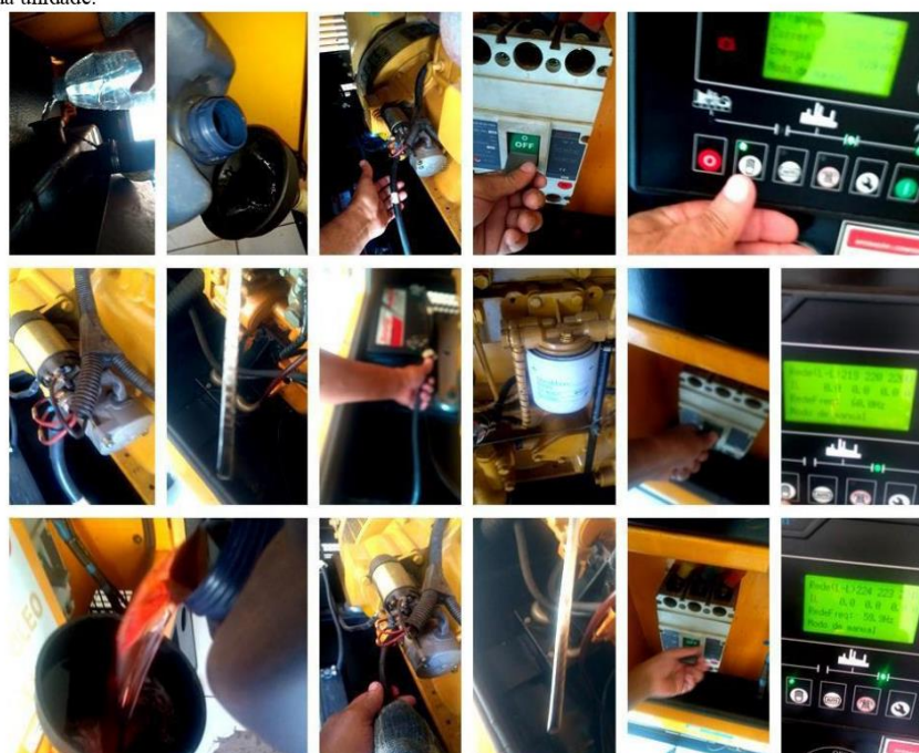
MAIO/2022: reforma/manutenção – Partida, pressão do óleo, água e reabastecimento do gerador da unidade.
