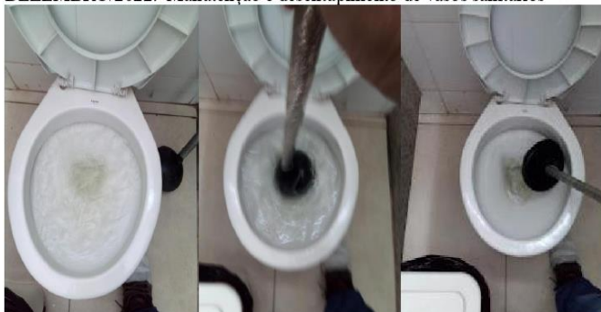
DEZEMBRO/2022: Manutenção e desentupimento de vasos sanitários
