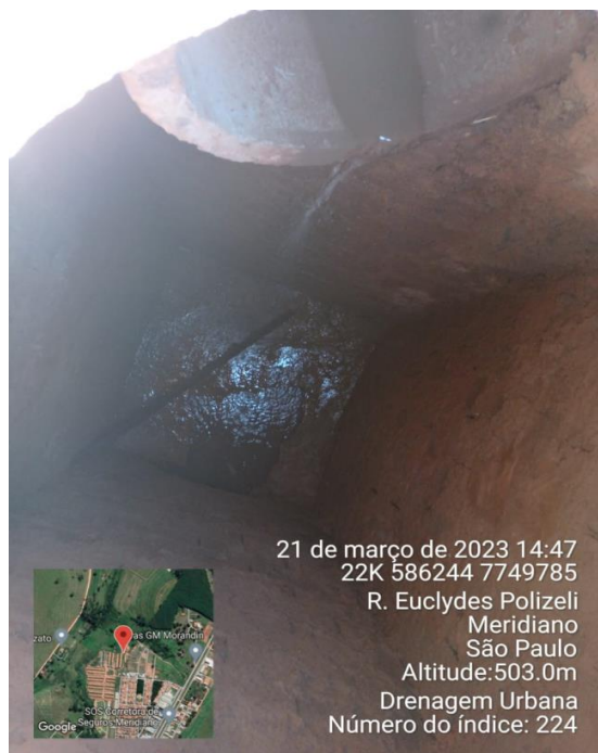
Figura 3: Abertura de buraco no fundo do poço de visita
