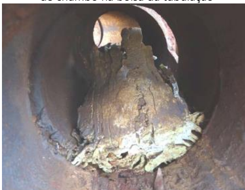
Figura 164. Vista de incrustação pela utilização de chumbo na bolsa da tubulação
