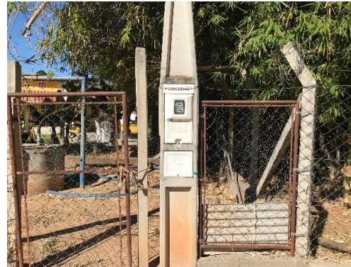
Figura 139. Vista do portão de acesso e ponto de entrada de energia elétrica.
