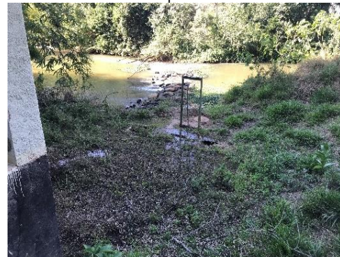
Figura 19. Vista Geral da Captação 02 no rio do peixe.
