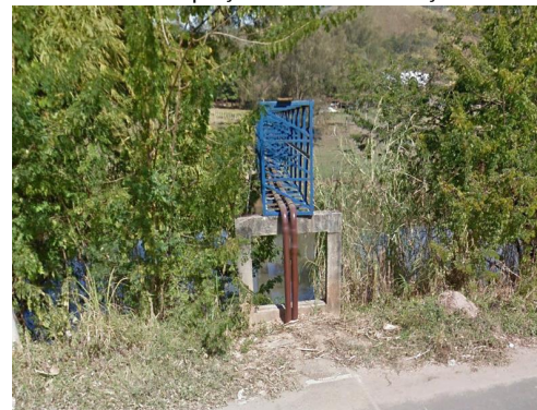
Figura 145. Vista da margem direita da travessia e do poço de visita de lançamento.
