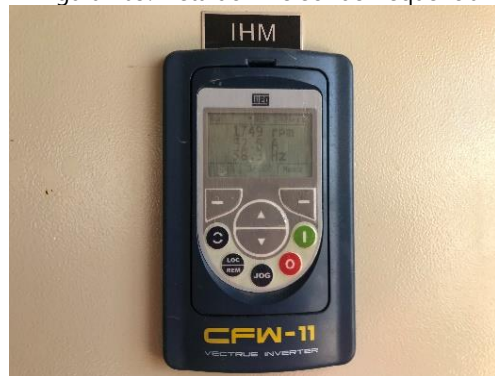
Figura 109. Vista do Inversor de frequência
