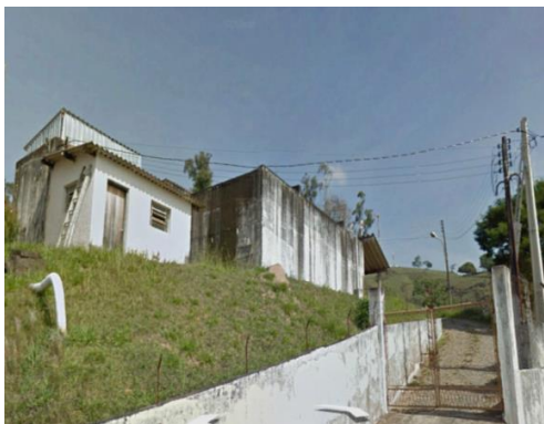
Figura 83. Vista da entrada da ETA.
