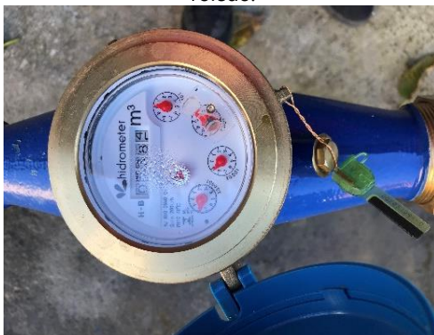
Figura 26. Vista do hidrômetro do Poço 01 - João Toledo.
