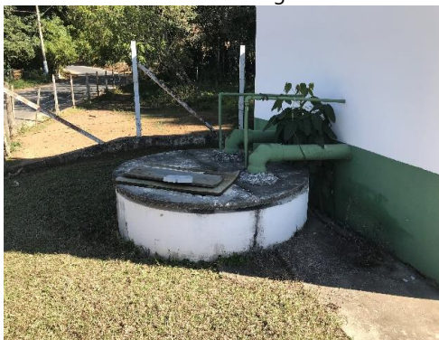
Figura 146. Vista geral do poço da estação elevatória de esgoto 3.
