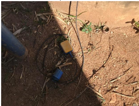
Figura 140. Vista do dispositivo de acionamento dos motores do tipo chave de boia elétrica.
