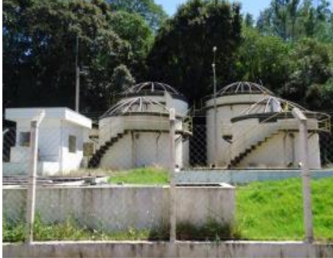
Figura 118. Vista geral da ETE.
