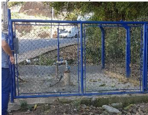
Figura 24. Vista Geral do Poço 01 - João Toledo.
