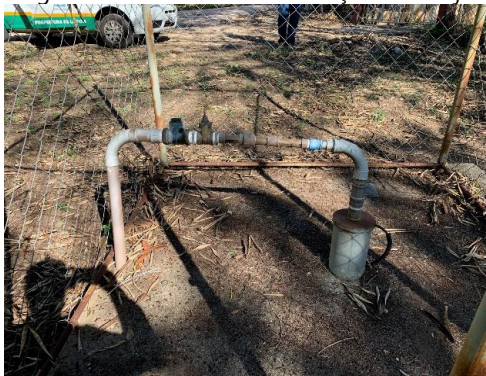
Figura 63. Vista barrilete do Poço P08 – Laje.
