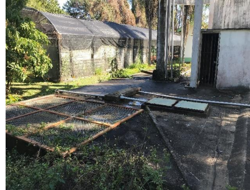
Figura 115. Vista da EEAT 03 – Prefeitura.
