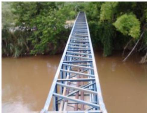
Figura 144. Vista da travessia metálica sobre o rio do Peixe.
