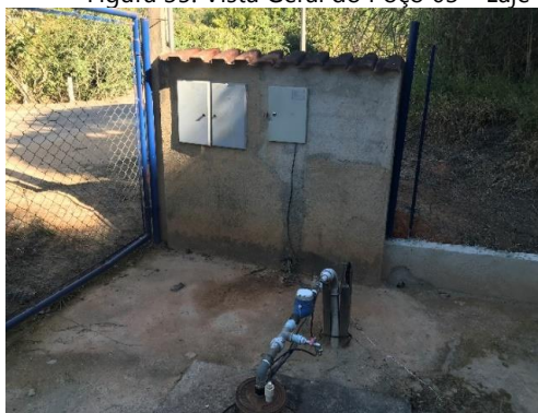
Figura 35. Vista Geral do Poço 03 – Laje
