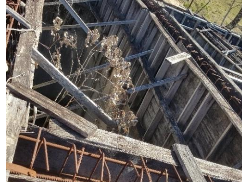
Figura 100. Expansão da ETA, obra paralisada
