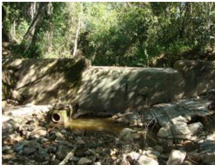
Figura 23. Vista da localização da captação da barragem do mosquito.
