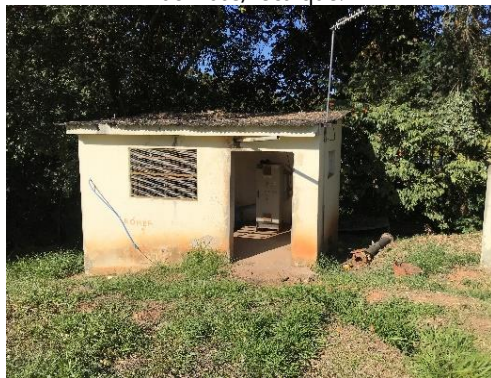
Figura 14. Vista Geral da casa de bombas/recalque.
