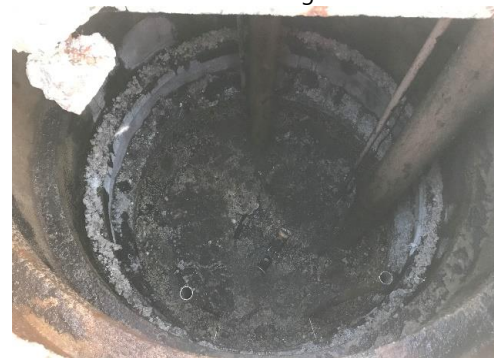
Figura 147. Vista do poço úmido da estação elevatória de esgoto 3.
