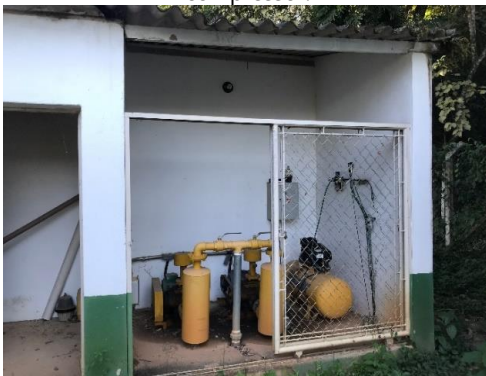
Figura 128. Vista do abrigo dos sopradores e compressor.
