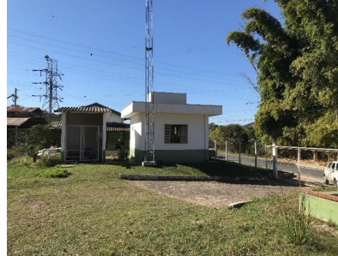
Figura 119. Vista da sala de operação.
