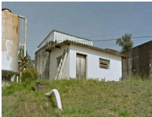
Figura 102. Vista Geral da Casa de Bombas da EEAT 1.
