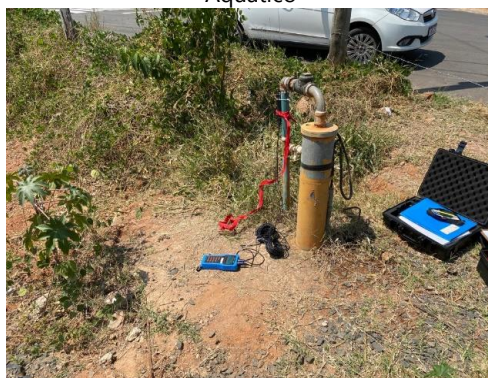
Figura 44. Vista Geral do Poço 05 – Parque Aquático
