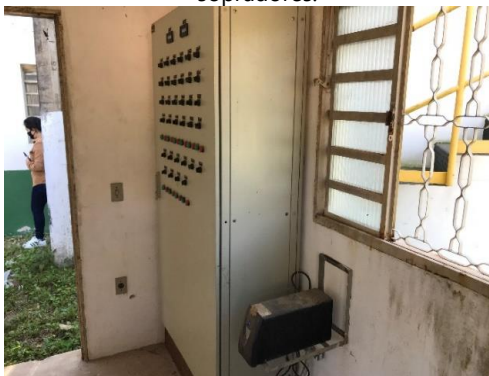
Figura 130. Vista do painel de comando dos sopradores.
