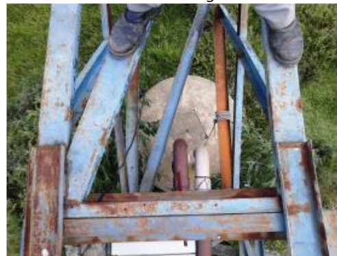
Figura 143. Vista do poço úmido da estação elevatória de esgoto 2.
