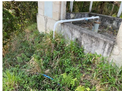
Figura 74. Vista do Poço P10 – Olaria.
