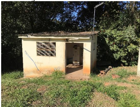
Figura 77. Faixada da EEAB 01.
