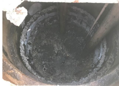
Figura 121. Vista do Poço da EEE 04.
