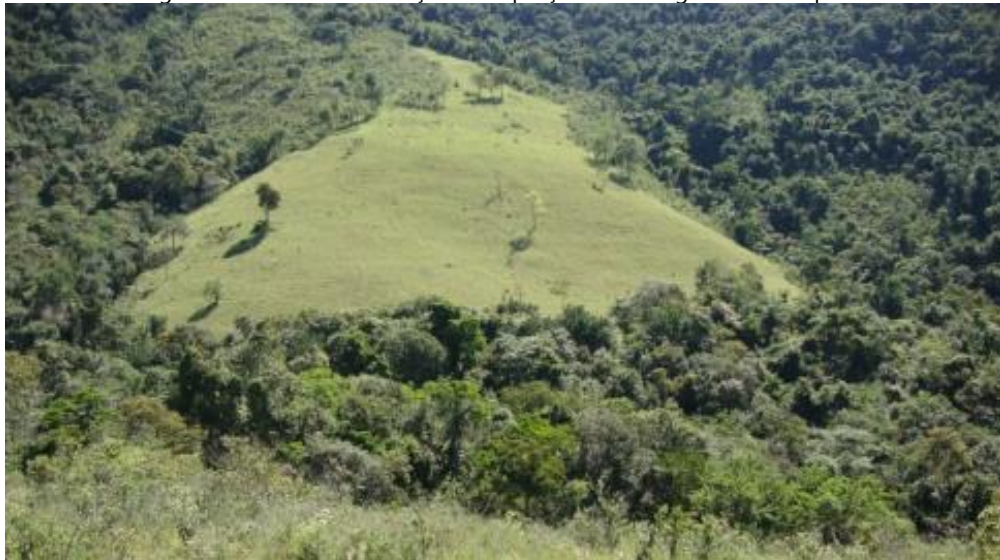
Figura 22. Vista da localização da captação da barragem do mosquito.
