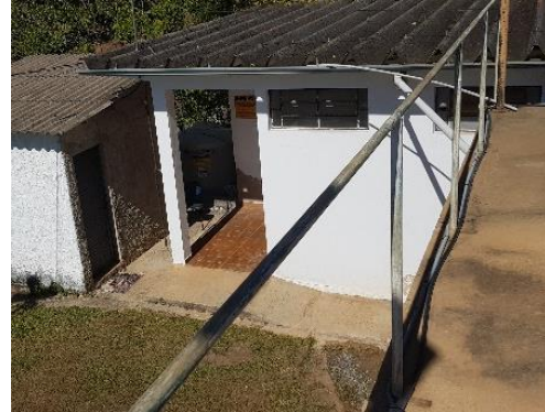
Figura 92. Vista da casa de química da ETA.
