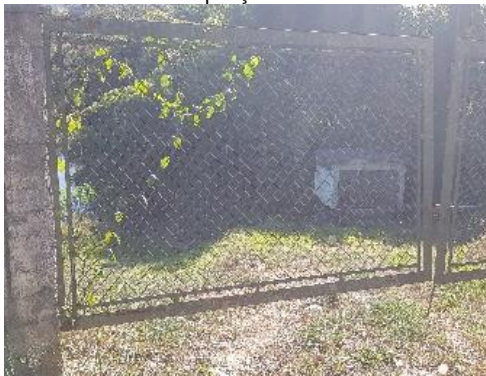
Figura 18. Vista Geral da entrada para a captação 02.
