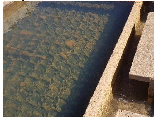
Figura 88. Vista do Módulo de filtração.
