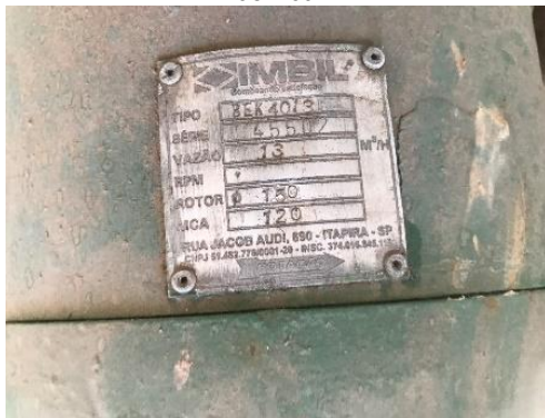
Figura 108. Vista da placa de identificação da bomba
