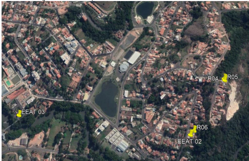
Figura 116. Localização da EEAT 03 e dos reservatórios R04 e R05.
