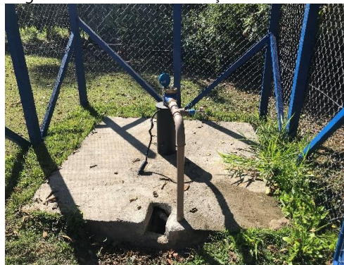
Figura 30. Vista Geral do Poço 02 – Prefeitura.
