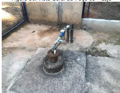
Figura 36. Vista Geral do Poço 03 – Laje
