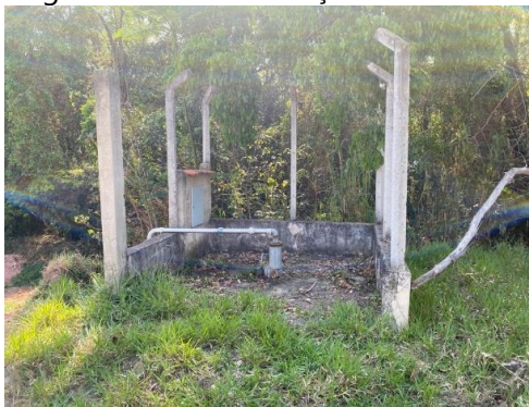
Figura 73. Vista do Poço P10 – Olaria.
