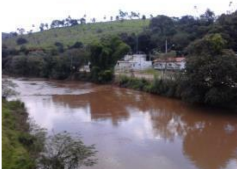
Figura 142. Vista geral do local de travessia da elevatória de esgoto 2.
