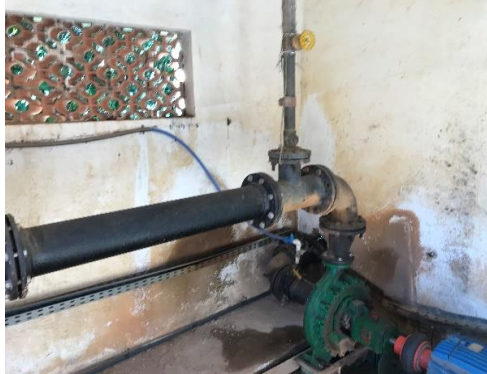
Figura 16. Vista Geral do barrilete de recalque da captação - 02.
