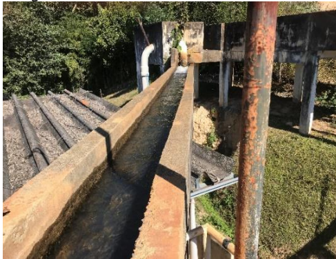
Figura 87. Vista do Canal da Calha Parshall.
