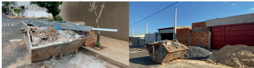
Figura 15: RCC acomodado em caçamba nas construções
