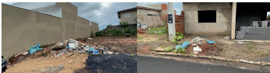
Figura 17: Construções/reformas sem caçamba
