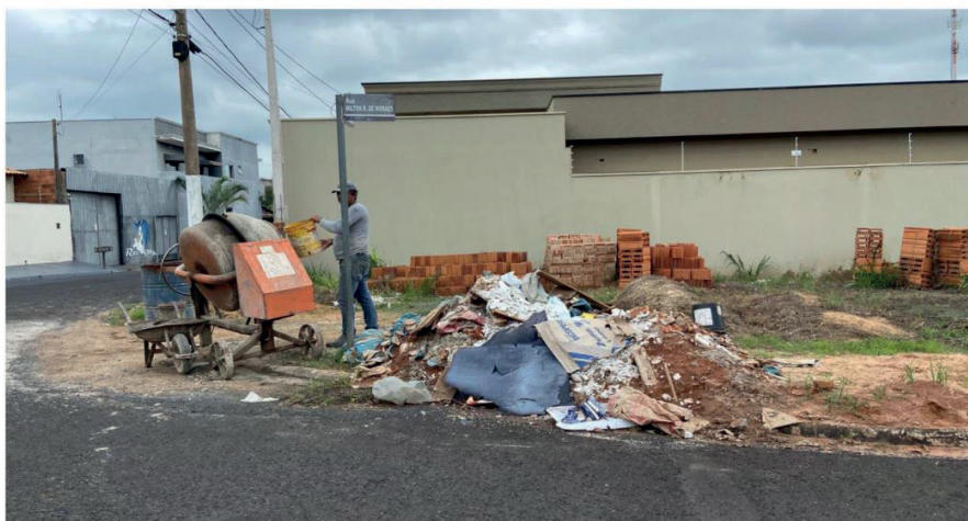
Figura 16: Construção sem caçamba
