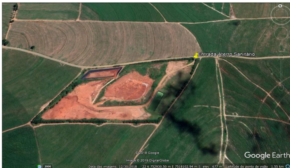
Imagem 9 - Localização do Aterro Sanitário
