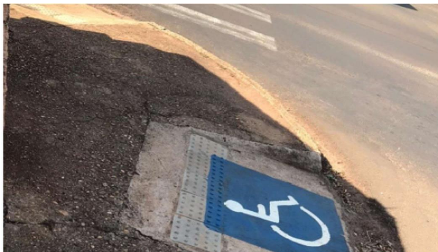
Figura 24 - Rampa fora de norma NBR ABNT 9050 - Proximidade da esquina
