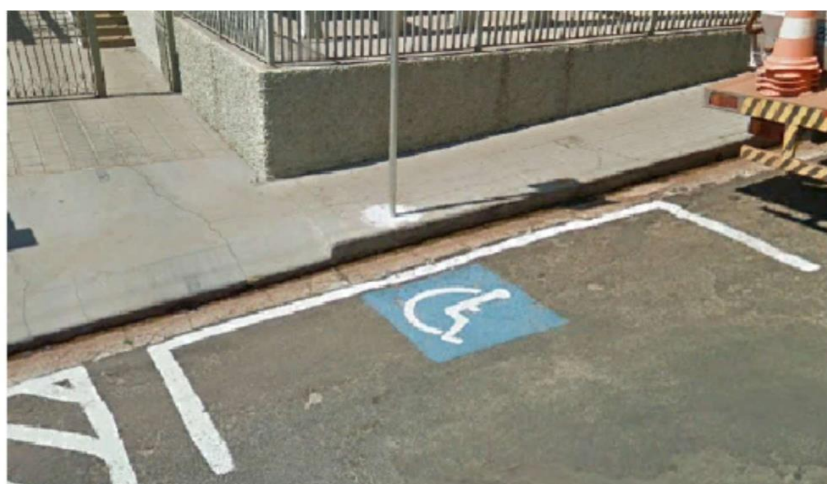
Figura 21 - Falta de padronização nas vagas de PCD
