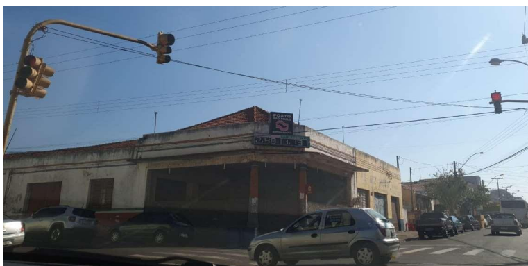
Figura 41 - Semáfora em “i” na Rua Vereador Irio Color Bombonatti
