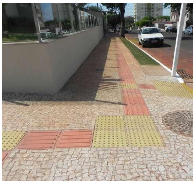
Imagem 1 - Piso Tátil instalado na Cidade
