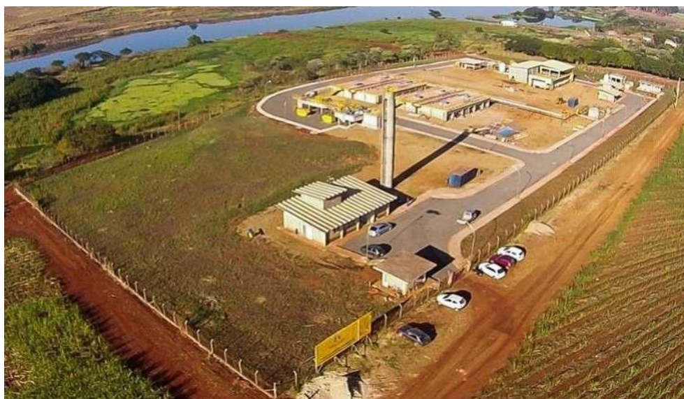
Imagem 8 - Estação de Tratamento de Esgoto (ETE)
