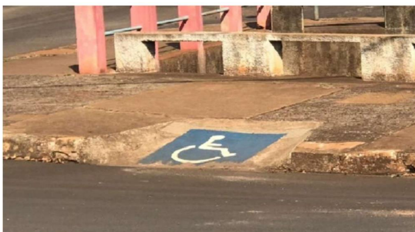
Figura 24 - Rampa fora de norma NBR ABNT 9050 - Proximidade da esquina
