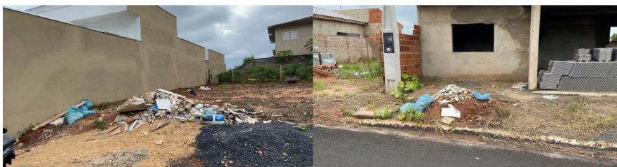
Figura 17: Construções/reformas sem caçamba
