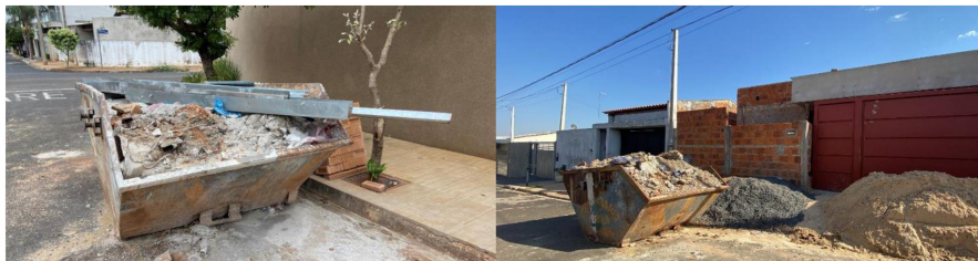
Figura 15: RCC acomodado em caçamba nas construções
