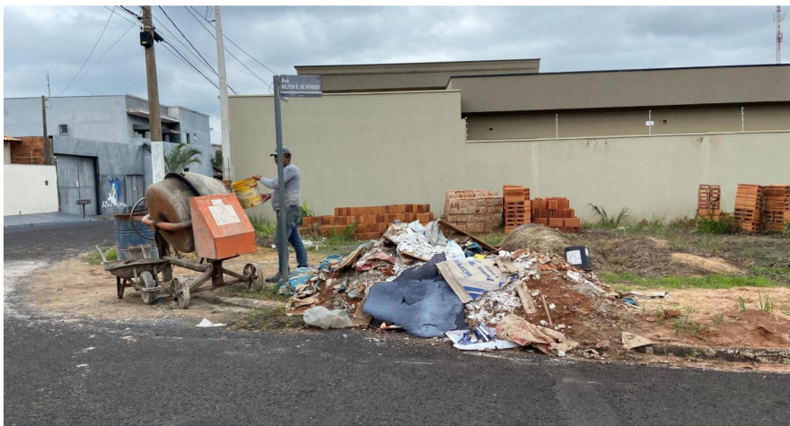
Figura 16: Construção sem caçamba
