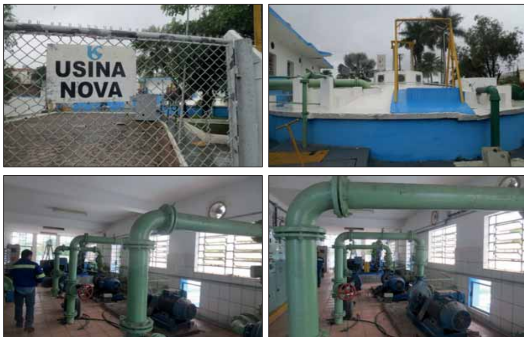
Figura 32 – Reservatório Usina Nova.
