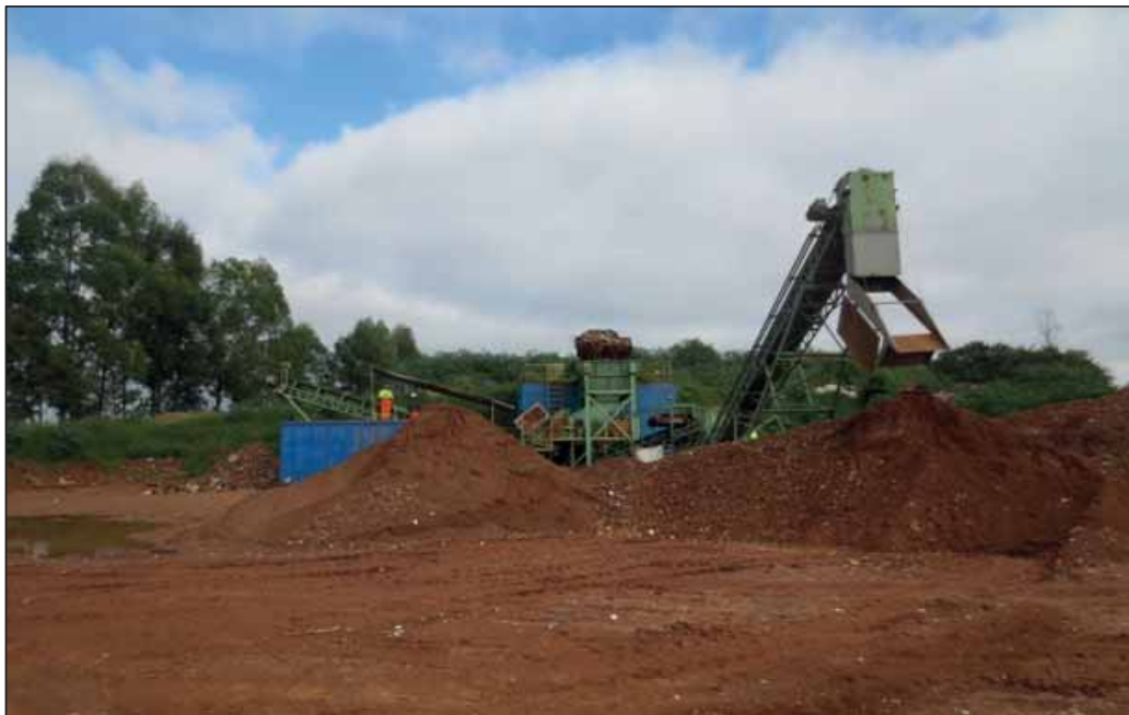
Figura 88 – Britador em funcionamento.
