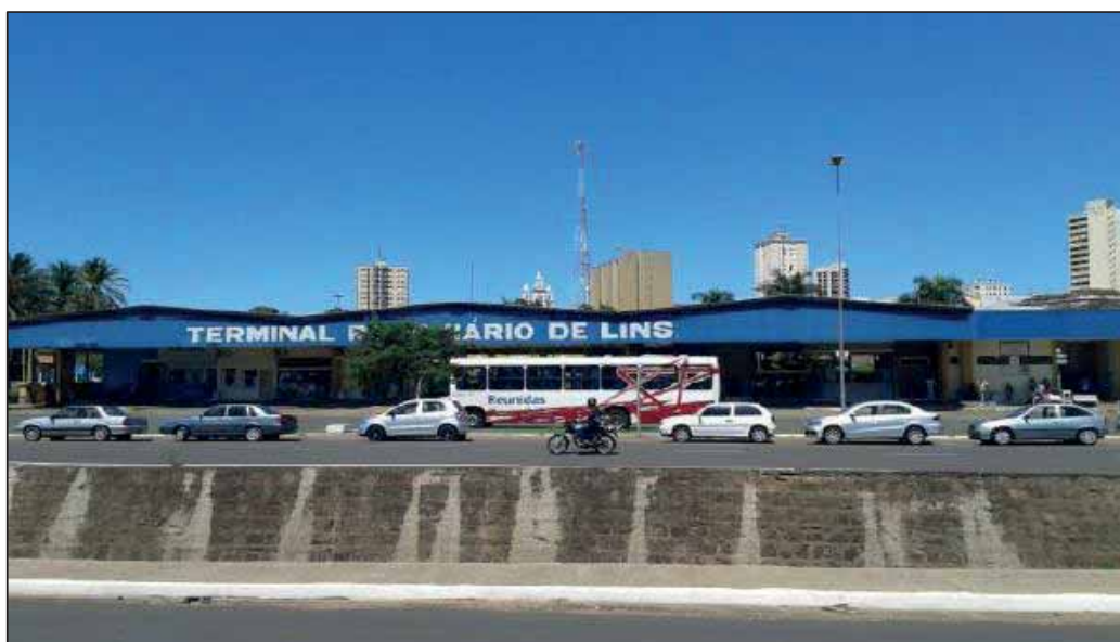
Figura 91 – Terminal rodoviário de Lins
