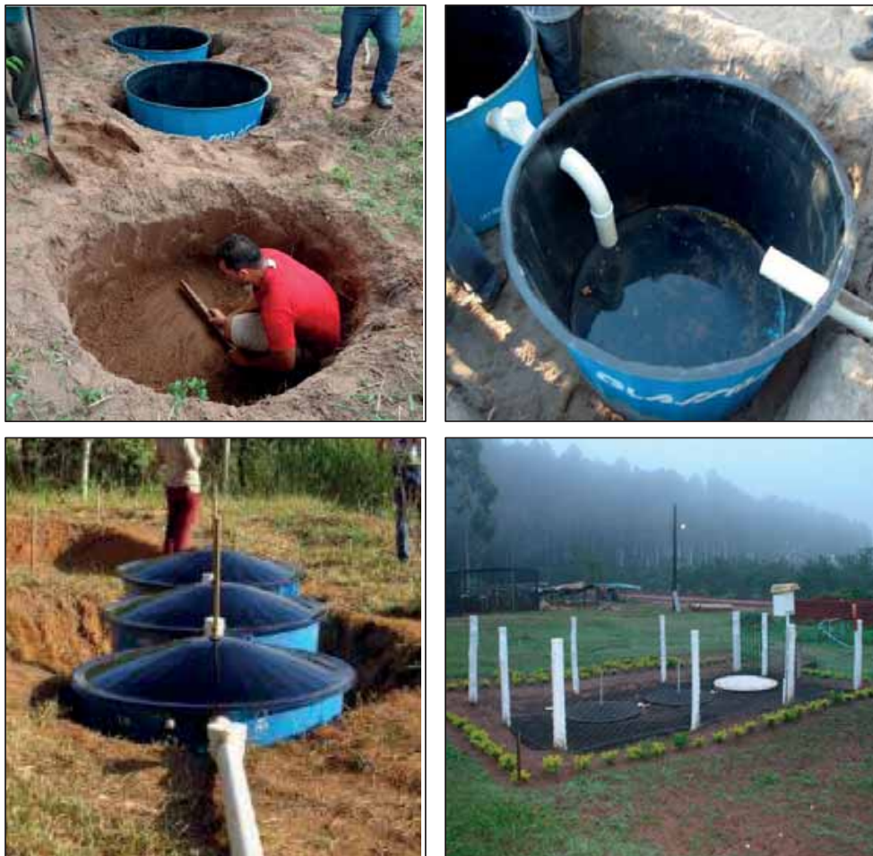
Figura 115 - Exemplo de Fossa Séptica Biodigestora.
