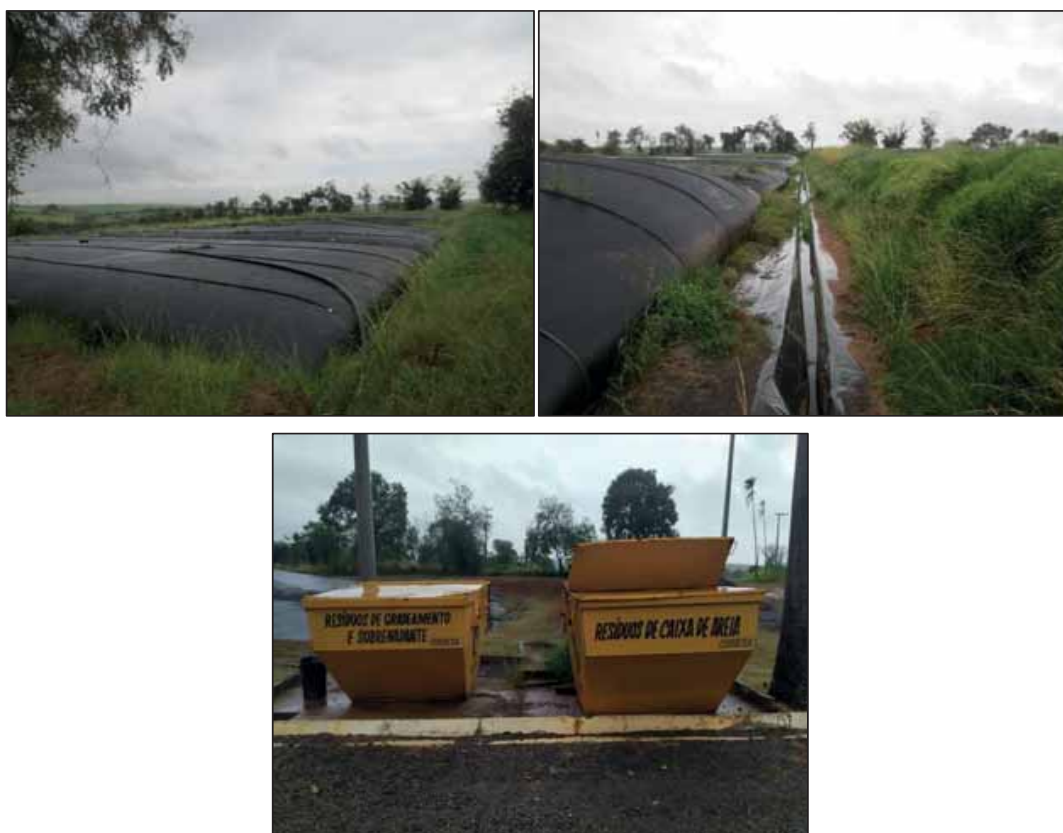
Figura 84 – Resíduos de saneamento (ETE de Lins).
