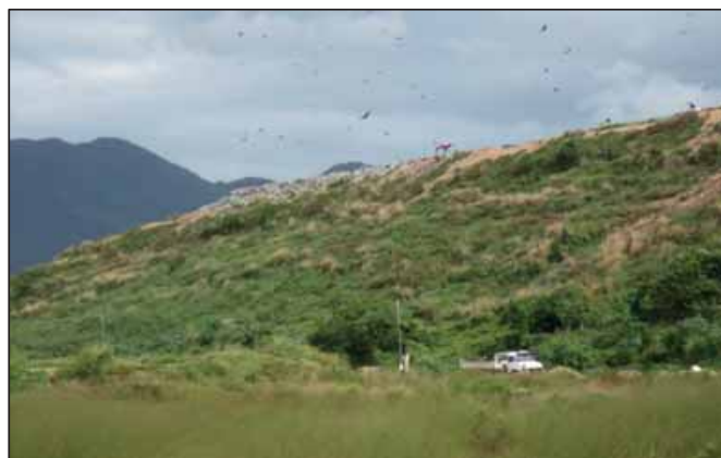
Figura 93 - Exemplo de aterro controlado.
