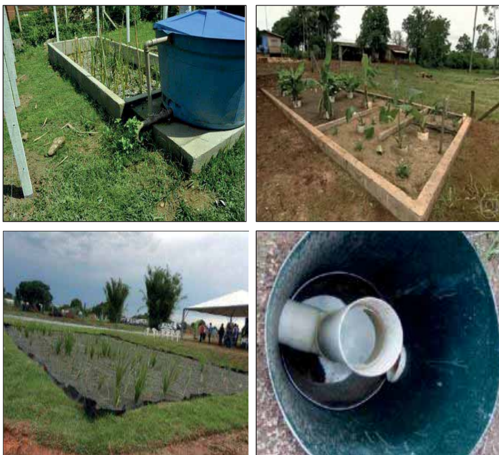
Figura 117 - Exemplo de zona de raízes e mecanismos de controle de PVC.
