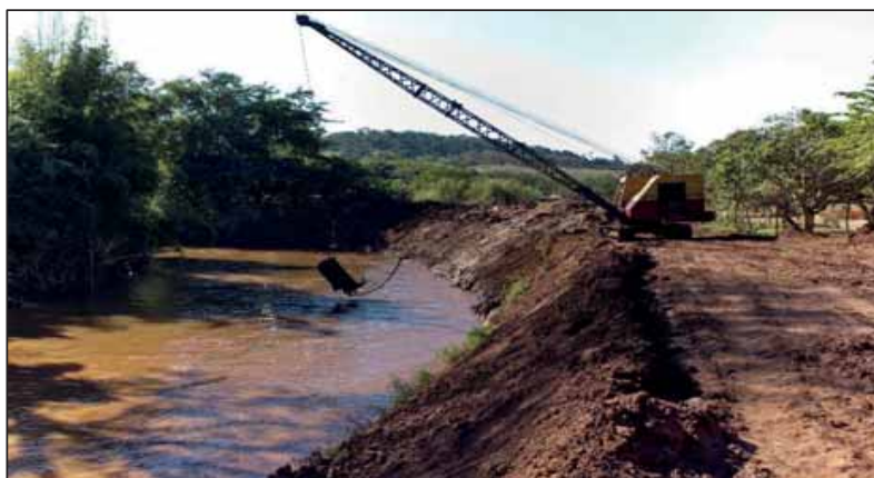
Figura 149 - Exemplo de alargamento e desassoreamento.
