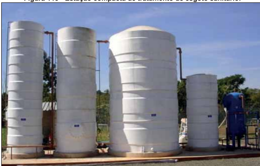
Figura 113 - Estação compacta de tratamento de esgoto sanitário.
