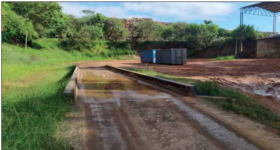
Figura 62 – Balança para pesagem de veículos (ATT).
