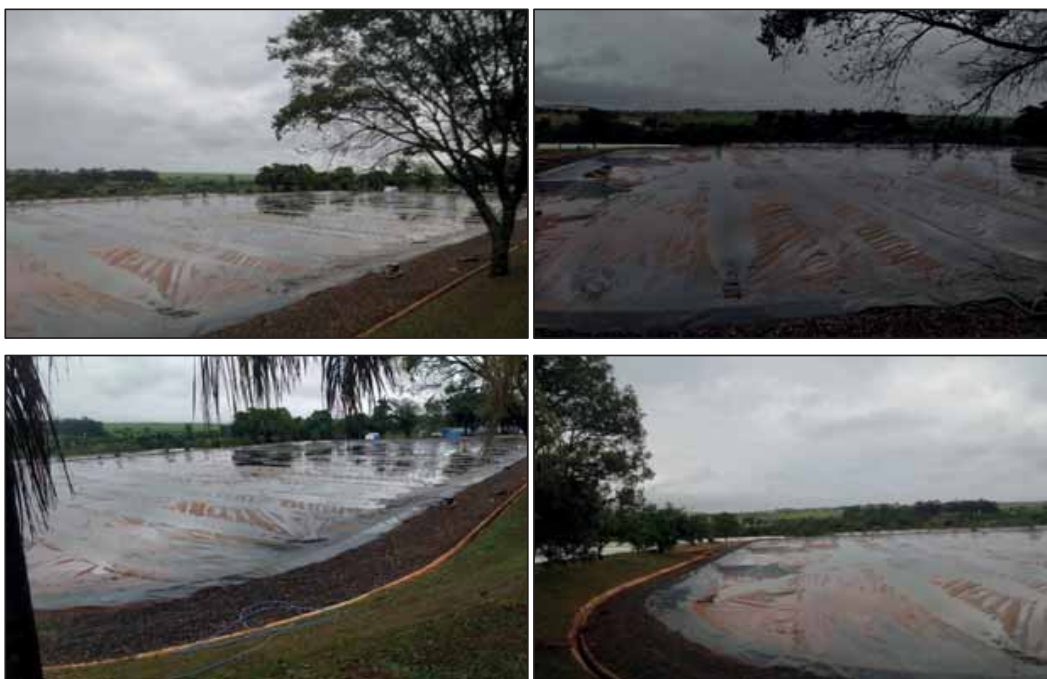
Figura 42 – Lagoas anaeróbias.
