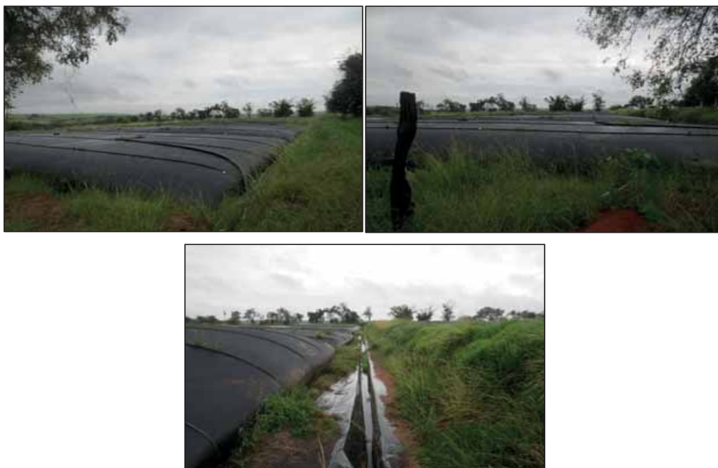
Figura 44 – Bags para armazenar, desaguar e desinfectar o resíduo proveniente da limpeza.
