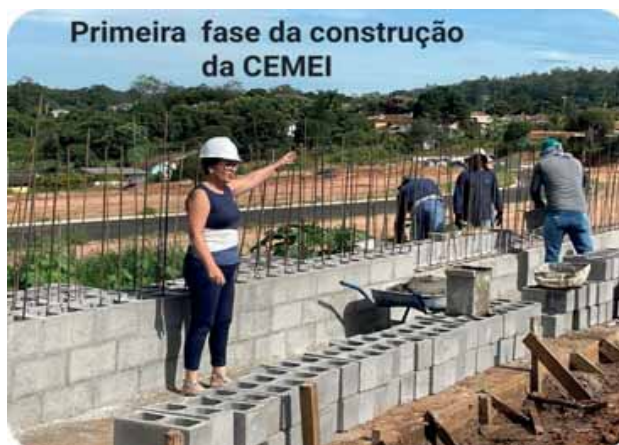
Imagem 16: Construção do CEMEI
