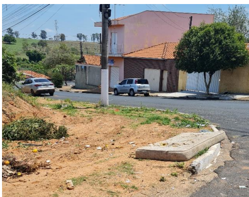
Figura 30 – Ponto com descarte incorreto Fonte: Amplar Engenharia
