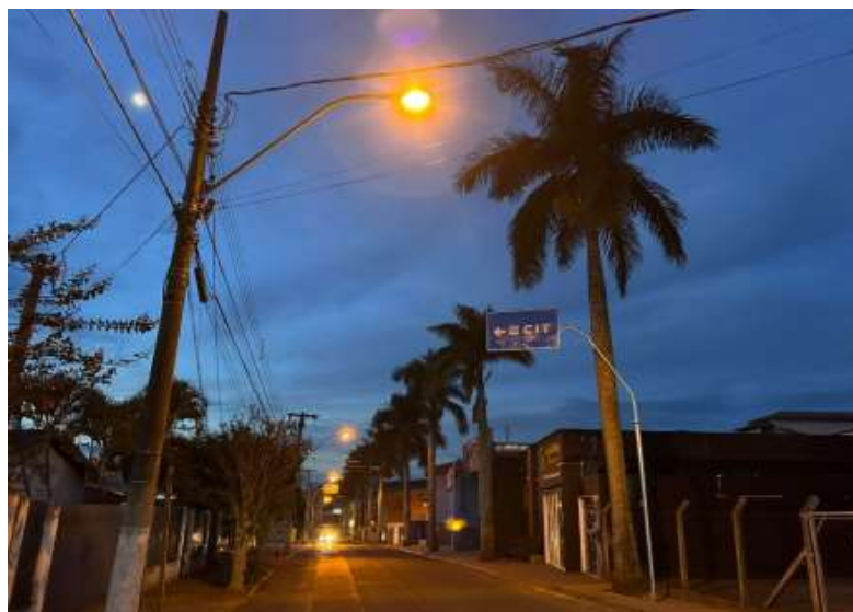
Figura 57 - Postes de iluminação na Rua Euzébio da Rocha Camargo
