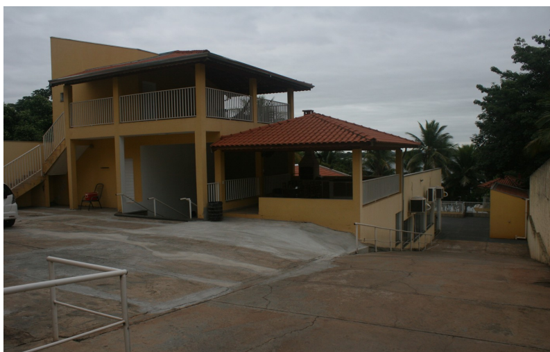
Figura 75: fachada interna da Pousada Sol
