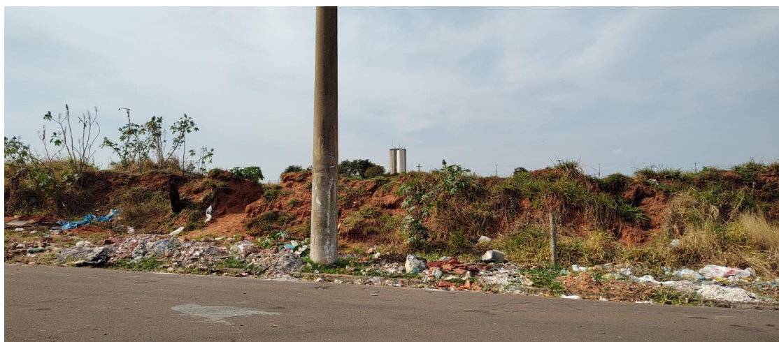
Imagem 16 – Ponto de descarte de RCC de forma irregular. Fonte: eBio, 2023.
