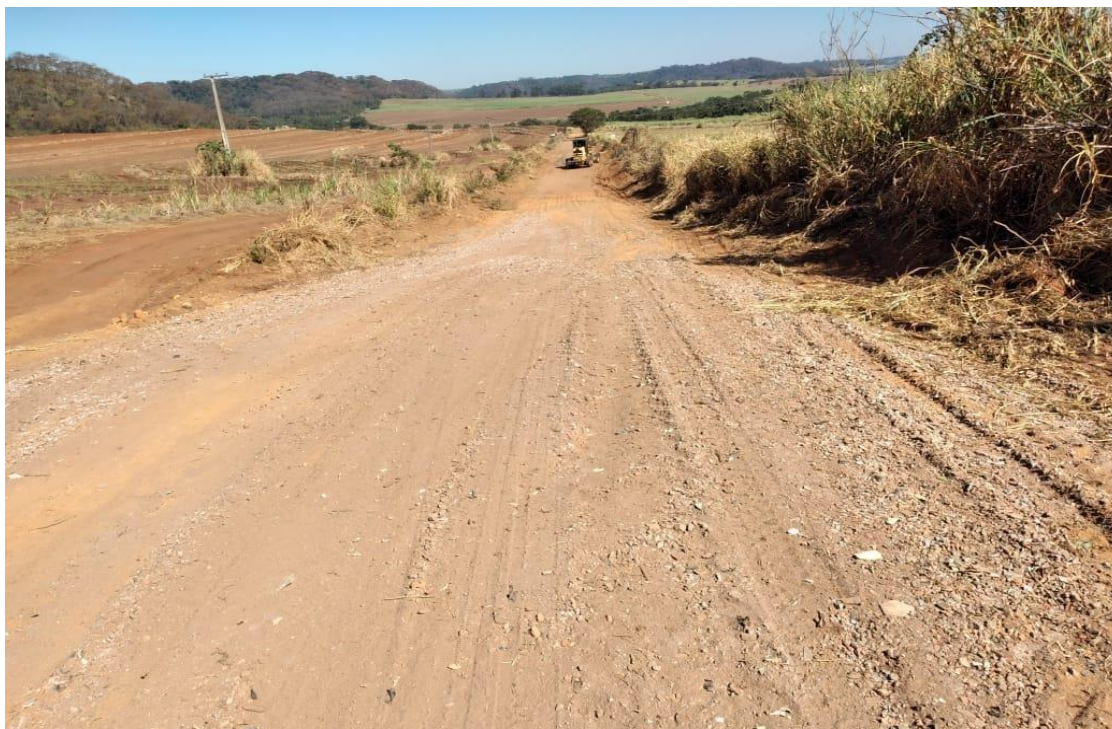
Imagem 23 – vista de estrada que recebeu melhorias com o uso dos RCC.
