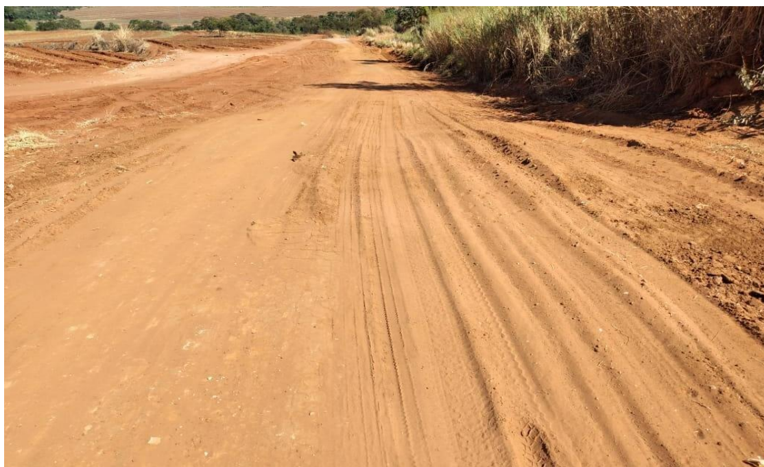
Imagem 22 – vista de estrada que recebeu melhorias com o uso dos RCC.
