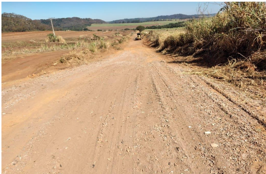
Imagem 24 – vista de estrada que recebeu melhorias com o uso dos RCC.
