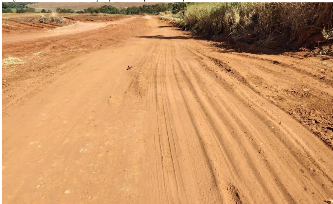
Imagem 23 – vista de estrada que recebeu melhorias com o uso dos RCC.
