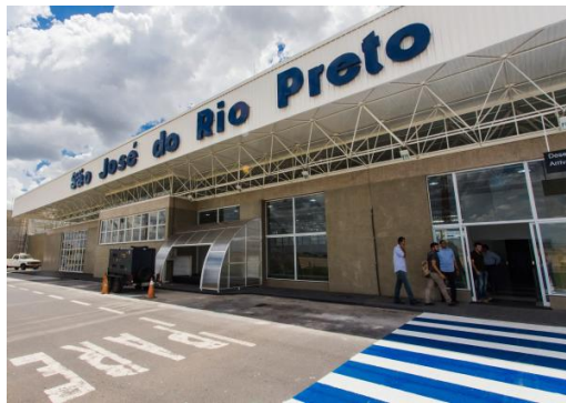
Foto 1: Fachada Aeroporto SJP
