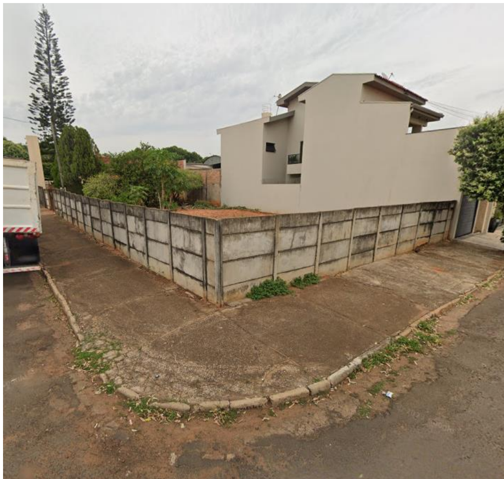
Registro fotográfico do terreno para construção do empreendimento
