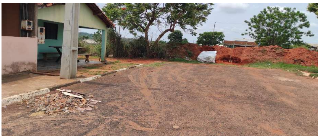
Figura 69: Vista da Rua Sete, em destaque ao fundo local do ponto 10.
