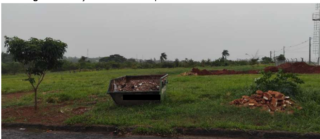
Figura 09: Caçamba contratada para o acondicionamento de resíduos.
