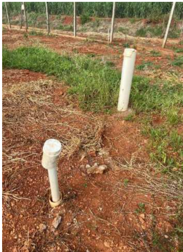
Figura 6-7 – Equipamentos de monitoramento das atividades do antigo lixão desativado em Laranjal Paulista/SP
