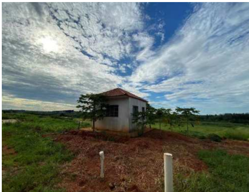
Figura 6-4 – Vista da futura área de Unidade de Triagem e Compostagem para resíduos de poda e capina em Laranjal Paulista/SP
