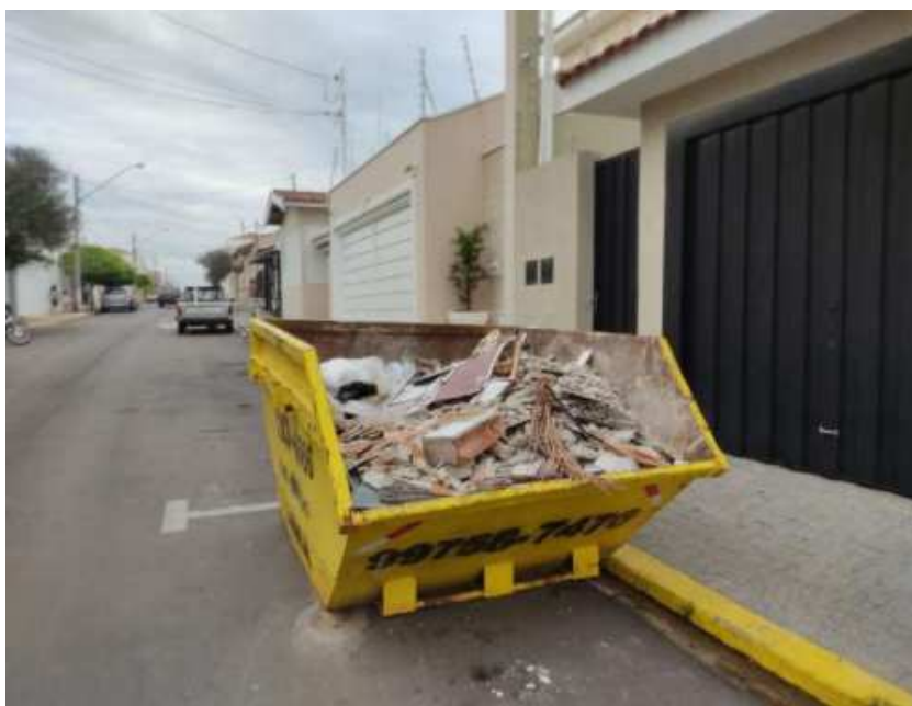
Figura 6-16 – Caçamba para acondicionamento dos RCC em Laranjal Paulista/SP
