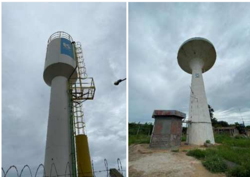
Figura 4-16 – Reservatórios de 50 m 3 e 150m 3 localizados no distrito de Maristela
