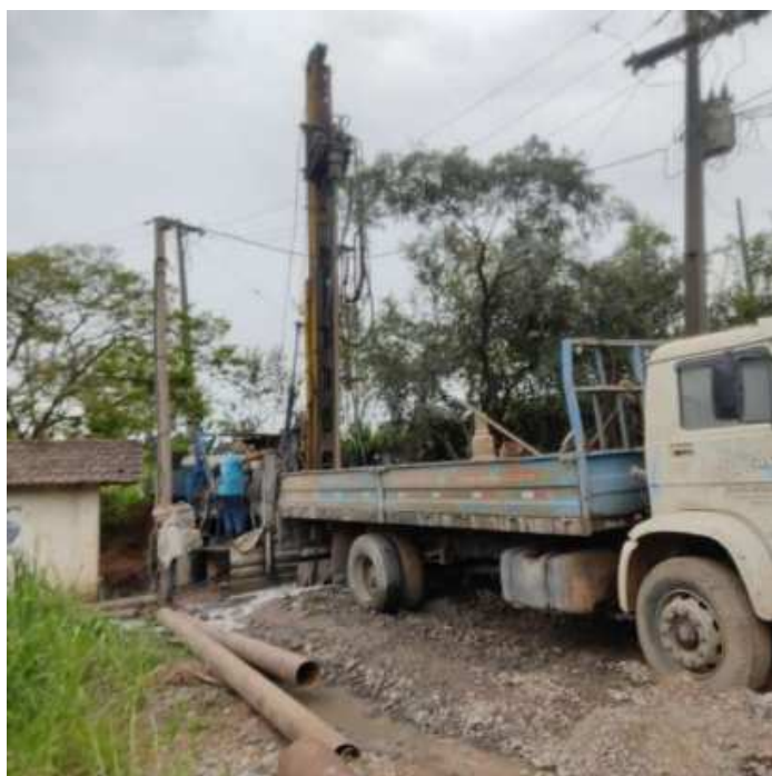
Figura 4-6 – Obra de perfuração do poço P5 no distrito de Laras
