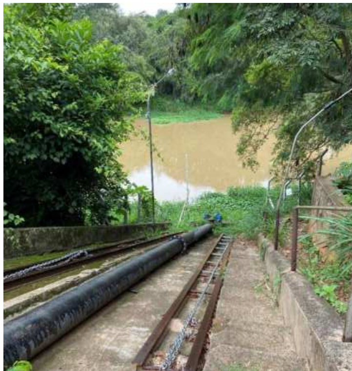
Figura 4-4 – Captação da água bruta no Rio Sorocaba em Laranjal Paulista/SP Fonte: Consórcio CM (2021).
