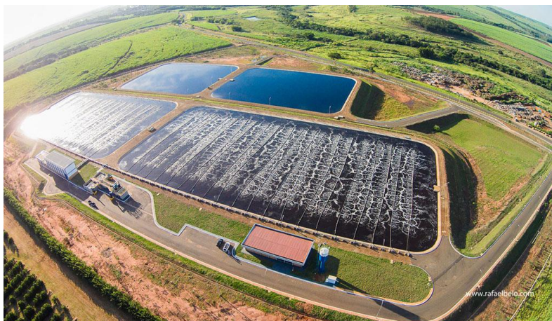
Figura 1: Vista aérea da Estação de Tratamento de Esgoto da cidade de Catanduva/SP.
