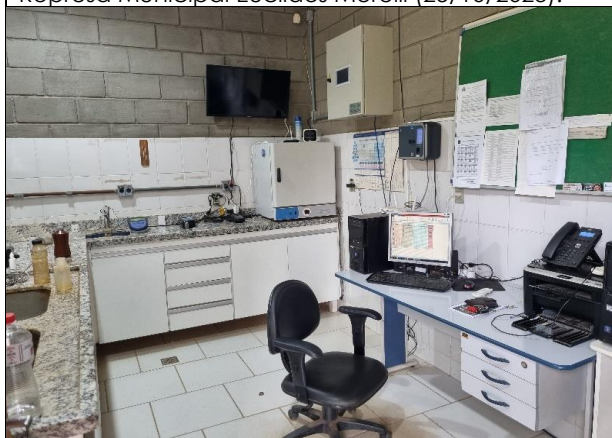
Foto 3: Laboratório de Análise de Qualidade de Água -ETA (25/10/2023).
