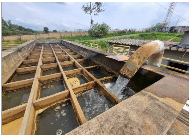
Foto 5: Estação de Tratamento de água - ETA (25/10/2023).
