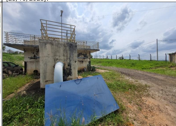
Foto 8: Estação de Tratamento de água - ETA (25/10/2023).
