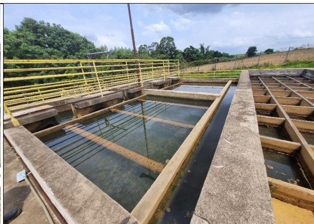
Foto 6: Estação de Tratamento de água - ETA (25/10/2023).
