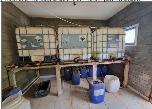
Foto 4: Casa de Químicos – ETA (25/10/2023).
