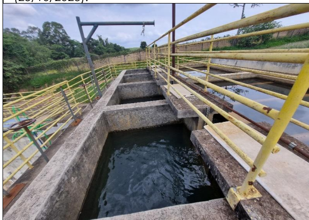
Foto 7: Estação de Tratamento de água - ETA (25/10/2023).
