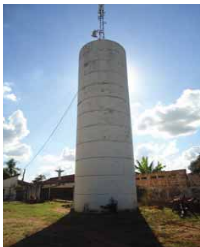
Foto 3.16 – Reservatório 01 (Sist. Prefeitura)
