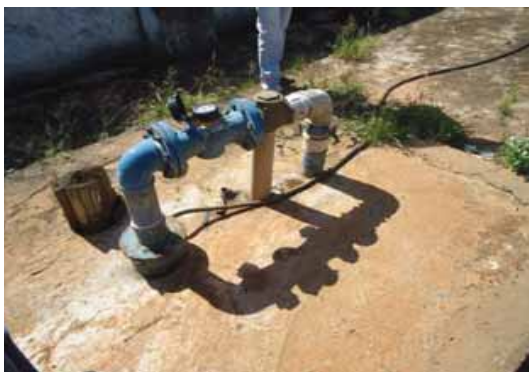
Foto 3.9 - Identificação do Poço: P-9
