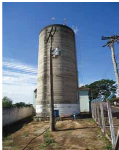
Foto 3.21 – Reservatório 06 (Sist. COHAB)
