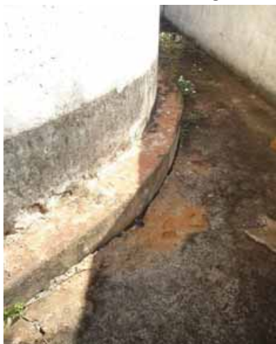
Foto 6.3 – R-06 – Rebaixamento da base
