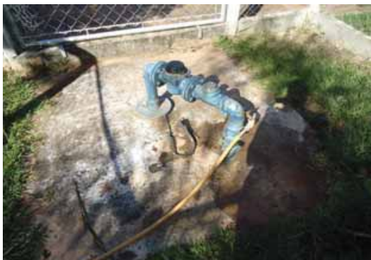
Foto 3.5 - Identificação do Poço: P-05
