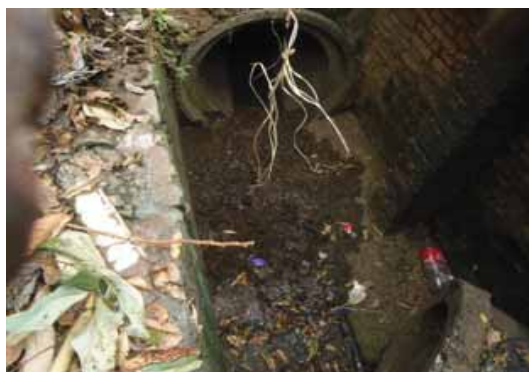
Foto 3.33 – Rede receptora da água de Boca de lobo
