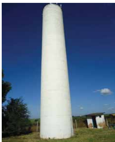
Foto 3.18 – Reservatório 03 (Sist. Creche)
