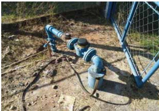
Foto 3.1 - Identificação do Poço: P-01
