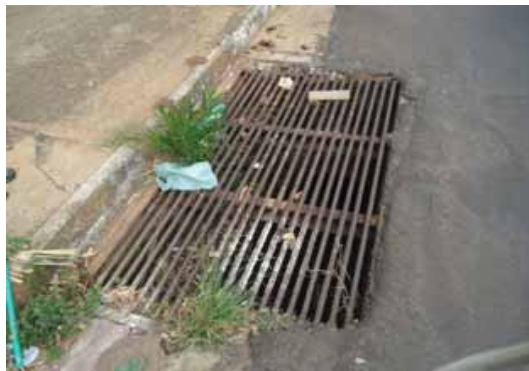
Foto 3.31 – Boca de lobo
