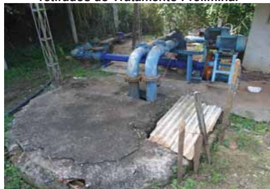
Foto 3.25 – EEE1 - Moto-bomba helicoidal marca GEREMIA
