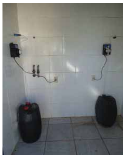
Foto 3.11- Unidade de Fluoretação e Cloração com bomba dosadora – Sistema Centro de Lazer – P4
