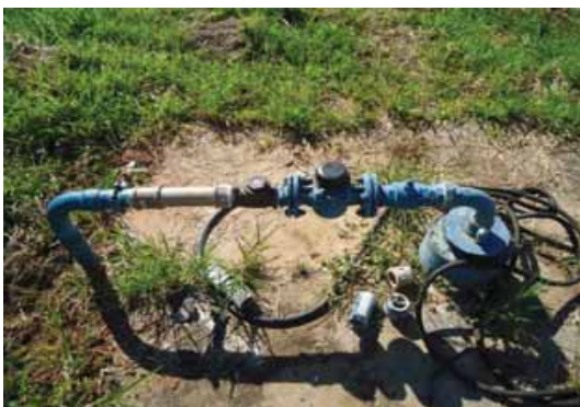
Foto 3.7 - Identificação do Poço: P-07
