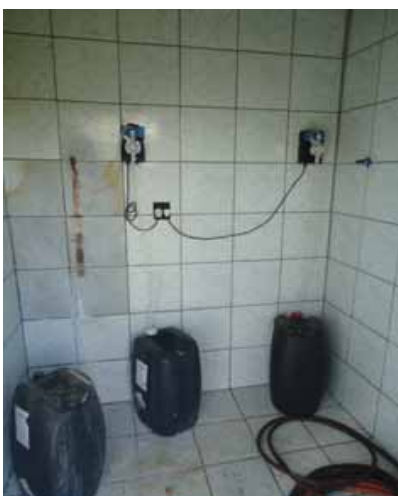
Foto 3.14- Unidade de Fluoretação e Cloração com bomba dosadora – Sistema Jd Beatriz – P7
