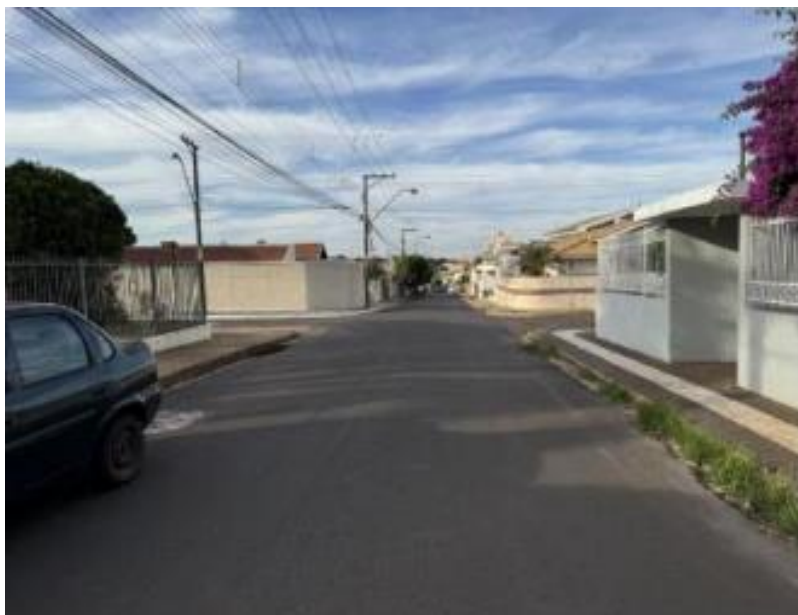
Foto 3: rua de acesso
