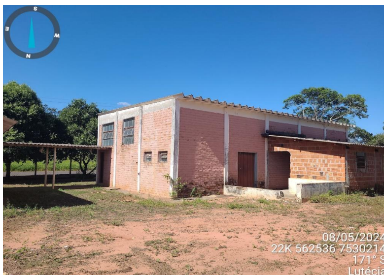
Figura 78 - Galpão onde era realizada triagem e armazenamento de recicláveis
