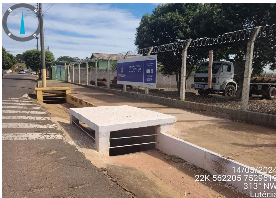
Figura 76 - Obra de Drenagem concluída no Município de Lutécia 2024
