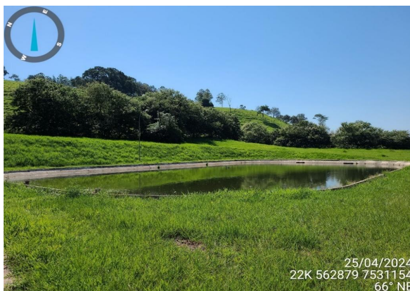
Figura 73 - Lagoa de estabilização da Estação de Tratamento de Efluente da SABESP
