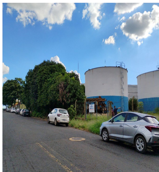
BRODOWSKI SANEAMENTO DISTRITO INDUSTRIAL
