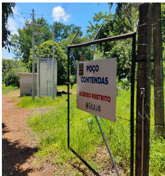
BRODOWSKI SANEAMENTO CONTENDAS I
