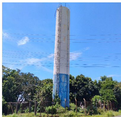
RESERVATORIO R7 - RESERVATORIO APOIADO ELEVADO
