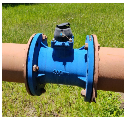
POCO CONTENDAS I - MEDIDOR DE VAZAO
