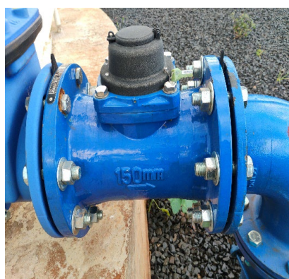
RESERVATORIO R19 - MEDIDOR DE VAZAO
