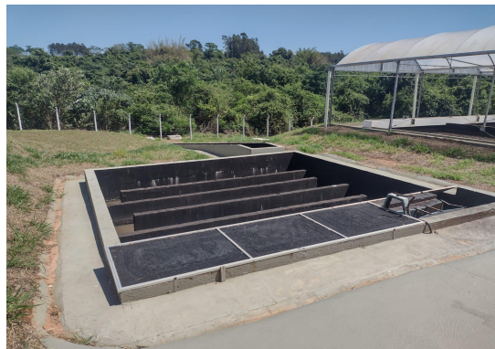
FIGURA 02: Reator anaeróbico de fluxo ascendente.
