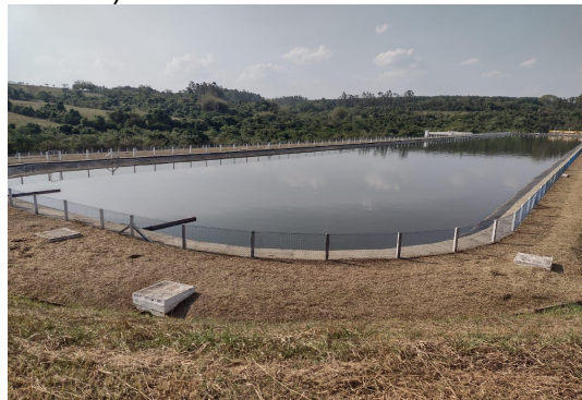
FIGURA 03: Lagoa de estabilização (vista externa)
