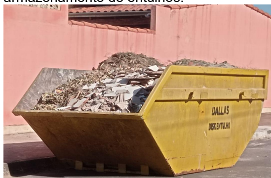
Figura 11: Caçamba utilizada no armazenamento de entulhos.
