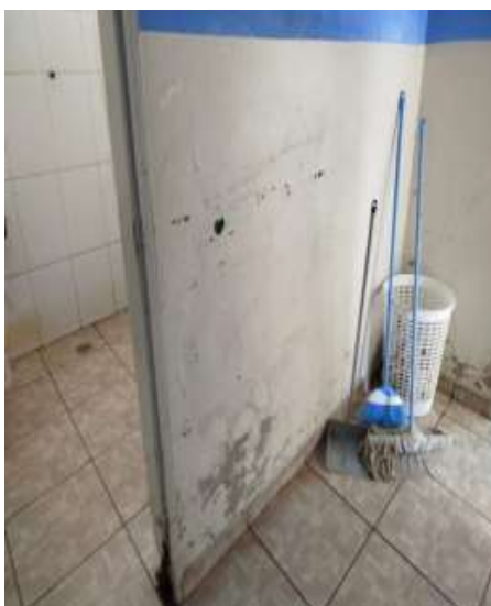
Fig. 16 Pintura desgastada
