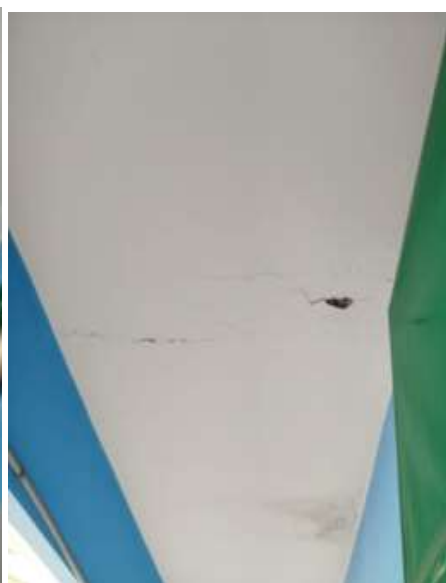
Fig. 5 - Trinca em laje
