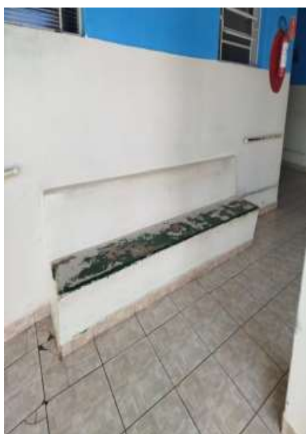
Fig. 17 Pintura em assentos de alvenaria
