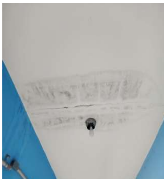
Fig. 5 - Trinca em laje
