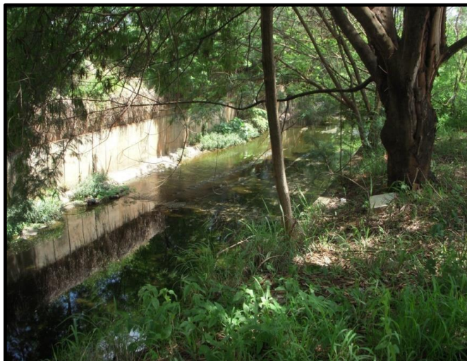
Córrego Machadinho – Próximo à travessia sob a R. Pres. Bernardes Estrangulamento do canal e vão da ponte – Necessita ampliação
