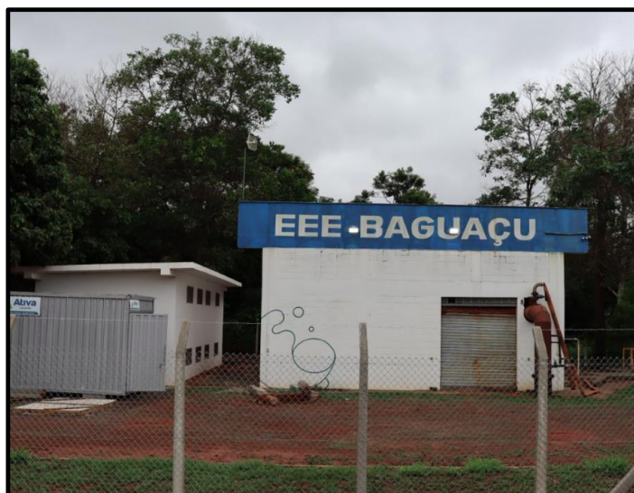
Estação Elevatória de Esgoto Baguaçu Recebe esgotos da região centro e sudeste e recalca para a ETE Baguaçu
