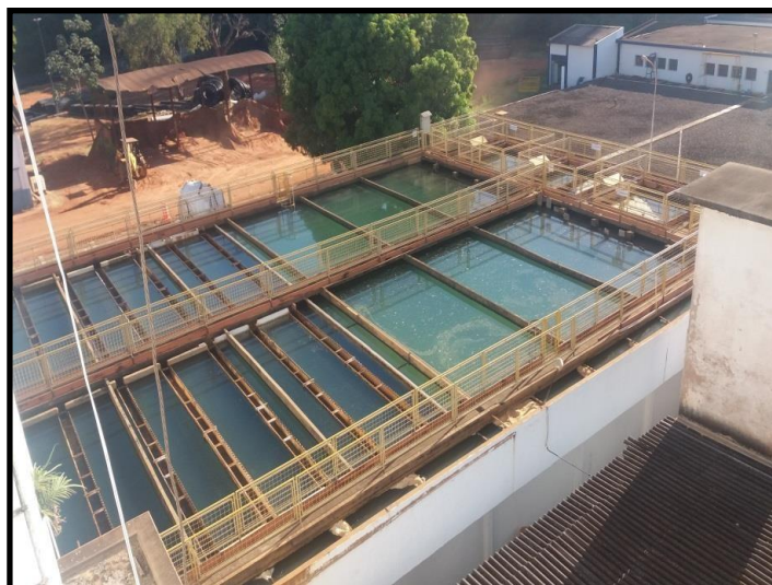
Sistema Produtos Baguaçu Decantadores da ETA Baguaçu – Remodelação em 2018
