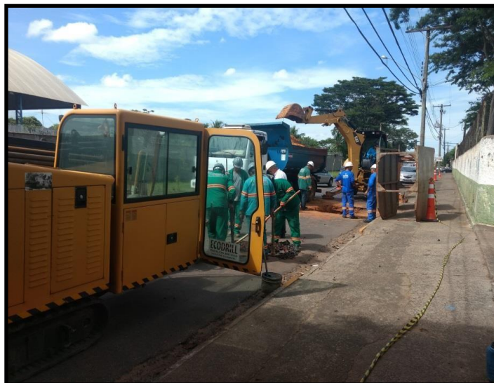
Obras em vias públicas Método Não Destrutivo – Escavação e posicionamento dos tubos sob a superfície
