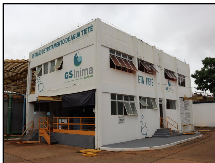
Sistema Produtor Tietê ETA Tietê – Remodelada em 2018
