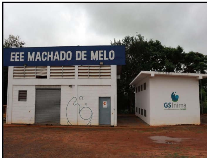
Recebe esgotos da região nordeste e recalca para a ETE Baguaçu
