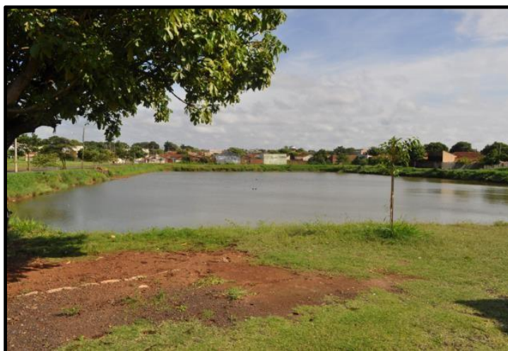
Abaixo: Lagoa das Flores – Nascentes do Córrego Machado de Melo Em estudos contenção de onda de cheia através de bombeamento – Sugere-se alternativa de extravasão por gravidade em galeria na Rua Estados Unidos
