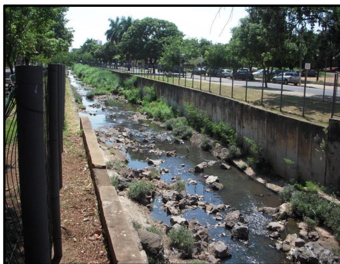
Canal do Córrego Machadinho – Av. Joaquim Pompeu de Toledo Necessidade de limpeza de vegetação e escombros de rocha
