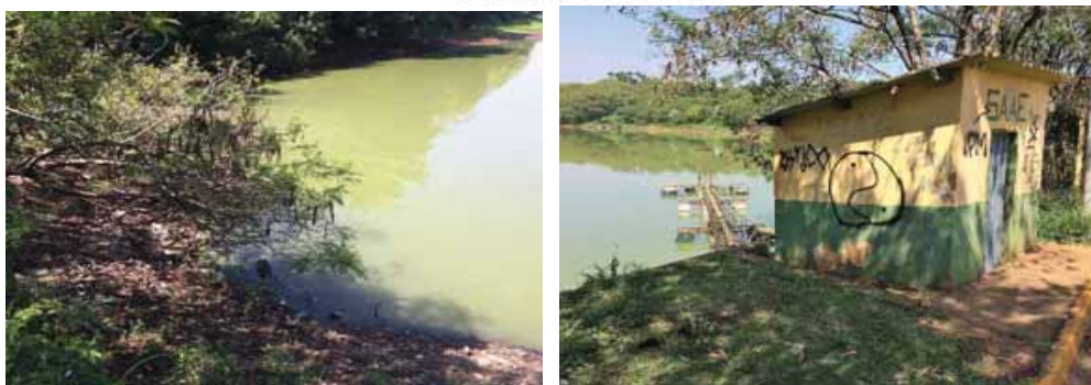
Fotos 9 e 10 – Captação de água bruta da Represa Bom Jesus II – Vista externa da margem esquerda da represa, vendo-se lixo doméstico e externa geral da instalação de captação e recalque, vendo-se o péssimo estado de conservação e sem segurança operacional.
