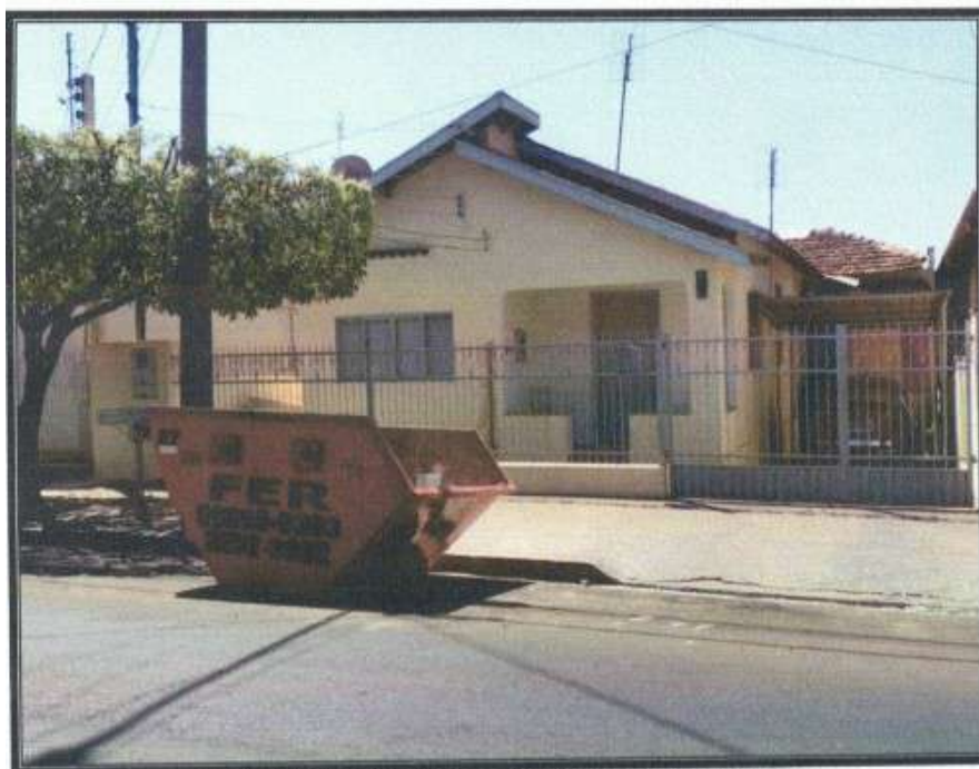
Figura 9: Caçamba com capacidade de 3m 3 para entulho
