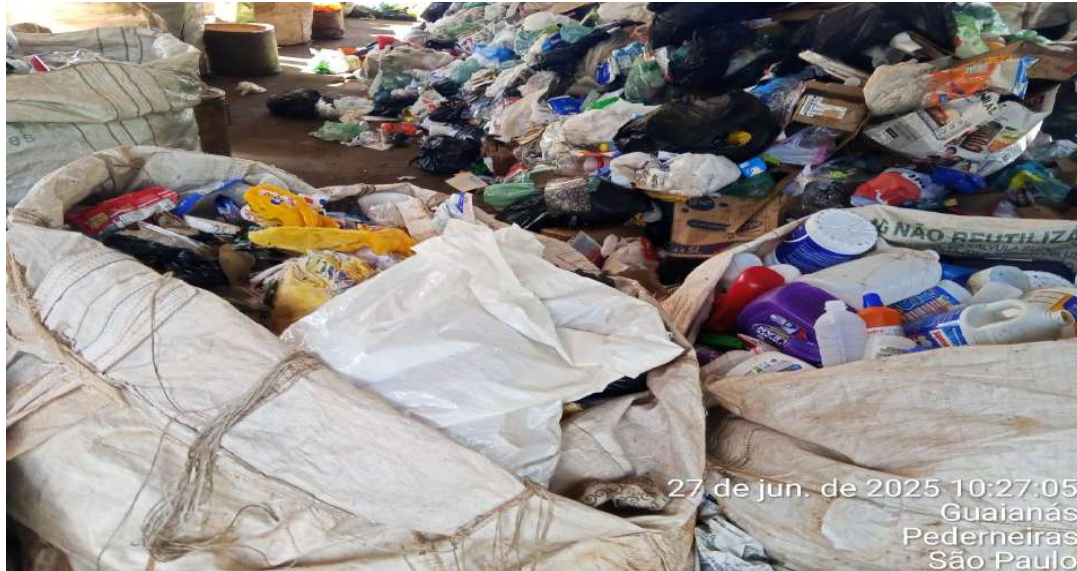
Foto 13 - Amostragem e separação dos diversos materiais encontrados nos resíduos coletados em Pederneiras/SP.
