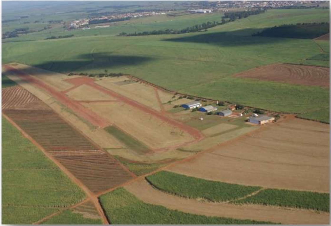
Foto 21 - Vista do Aeroporto de Pederneiras
