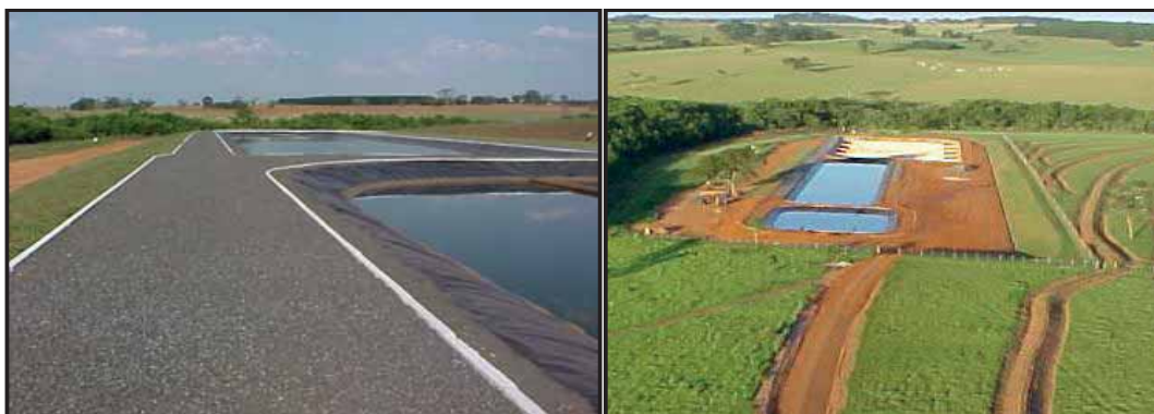
Foto 16: Estação de Tratamento de Esgotos de Simonsen
