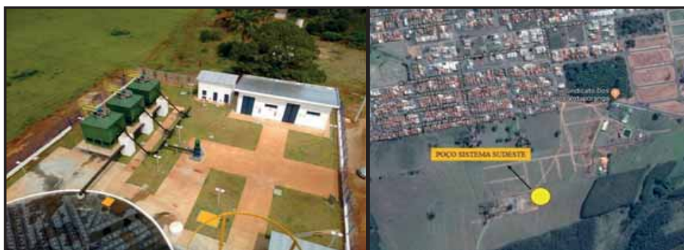
Foto 6: Imagem do poço profundo Zona Sudeste (2017)
