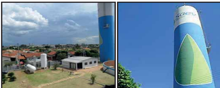
Foto 11: Reservatório Elevado - Poço Profundo Zona Norte
