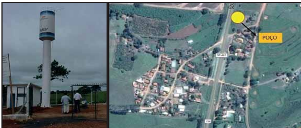
Foto 8: Imagem do Poço Vila Carvalho
