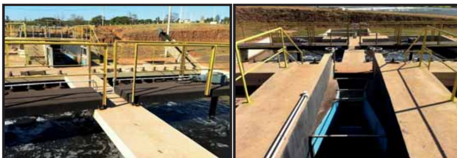
Foto 15: Caixa de Areia - Estação de Tratamento de Esgotos
