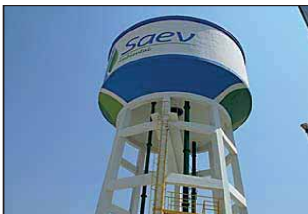
Foto 10: Reservatório Elevado- Estação de Tratamento de Água (ETA)
