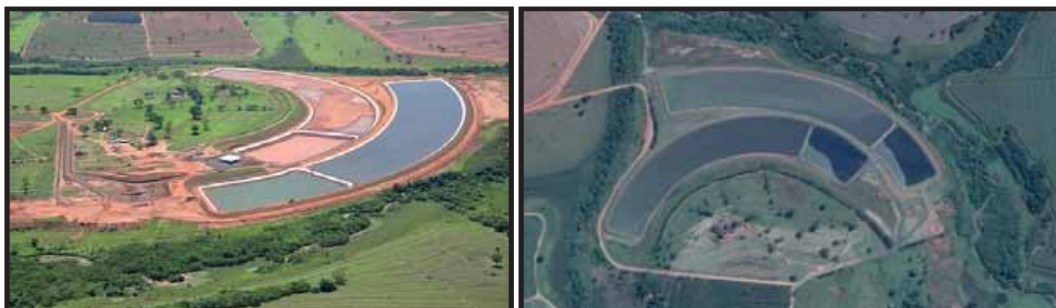
Foto 14: Imagem da Estação de Tratamento de Esgoto (ETE) de Votuporanga-SP
