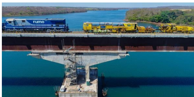
FOTO 1: Ponte Ferrovia Água Vermelho
