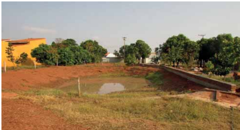
Fotografia 15 – Bacia 02 de contenção/detenção com dissipador de energia em Área Institucional do loteamento “Recanto do Sol” (Lote 31, Quadra 03) interligada a Rua 03
