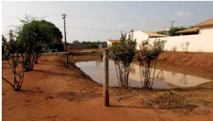
Fotografia 14 – Bacia 01 de contenção/detenção com dissipador de energia em Área Institucional do loteamento “Recanto das Águas” (Lote 31, Quadra 05)
