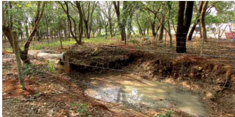
Fotografia 11 - Bacia de detenção/contenção cercada em Área Verde 3 (Quadra 03) do loteamento "Recanto das Águas"
