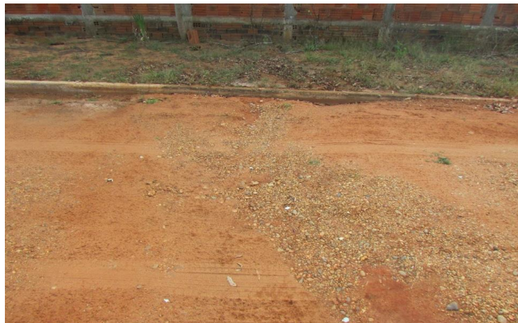
Fotografia 4 – Erosão laminar entre a Rua Pinheiros e a Rua das Orquídeas
