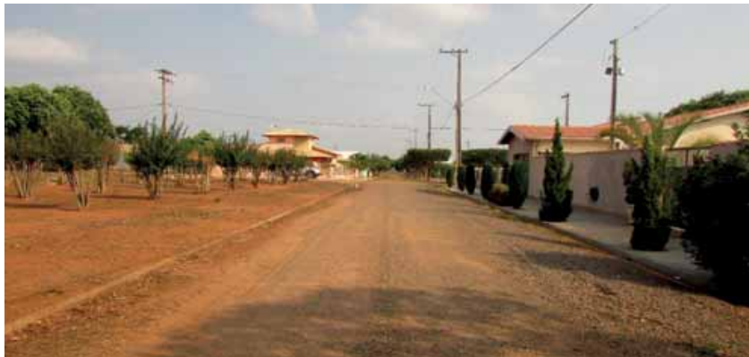
Fotografia 6 – Vias públicas (2) com guias, sarjetas, cascalho, rede de água, energia elétrica, iluminação pública e arborização dos passeios no loteamento “Recanto das Águas”
