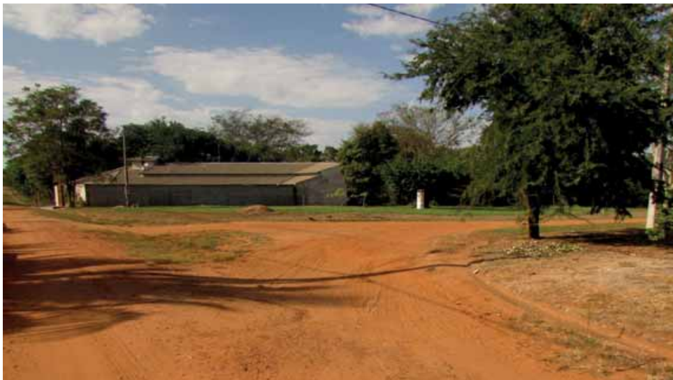
Fotografia 7 – Depressão existente na Rua Tamoios
