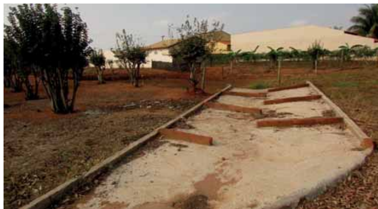
Fotografia 15 – Saída da Bacia 02 de contenção/detenção com dissipador de energia em Área Institucional do loteamento “Recanto das Águas” (Lote 31, Quadra 05)
