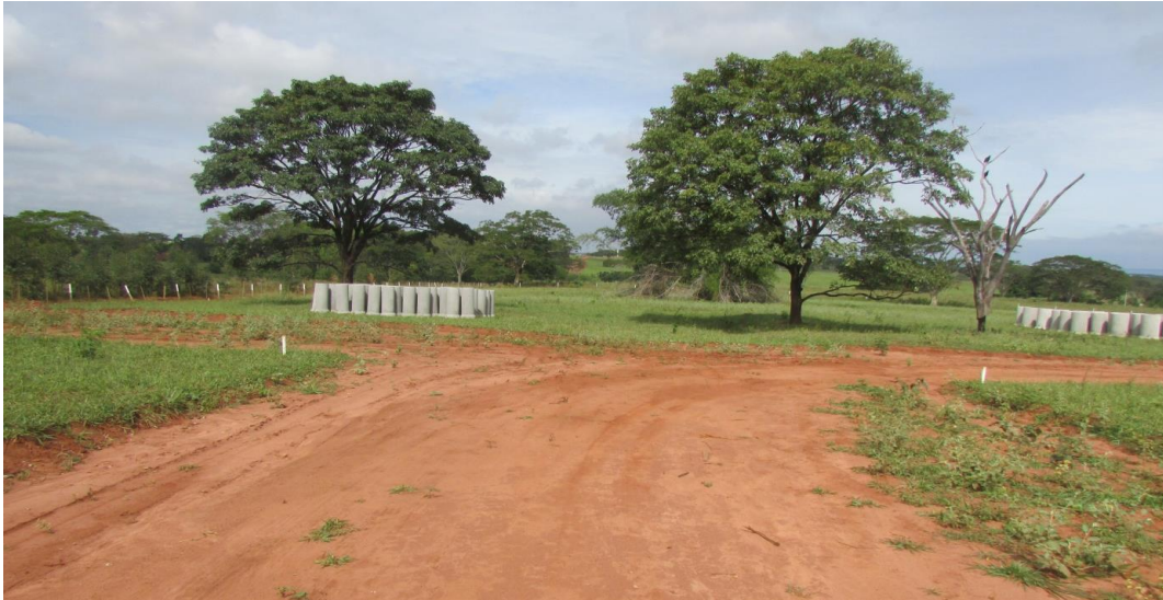
Fotografia 3 – Tubos de concreto para execução da rede de drenagem ao fundo
