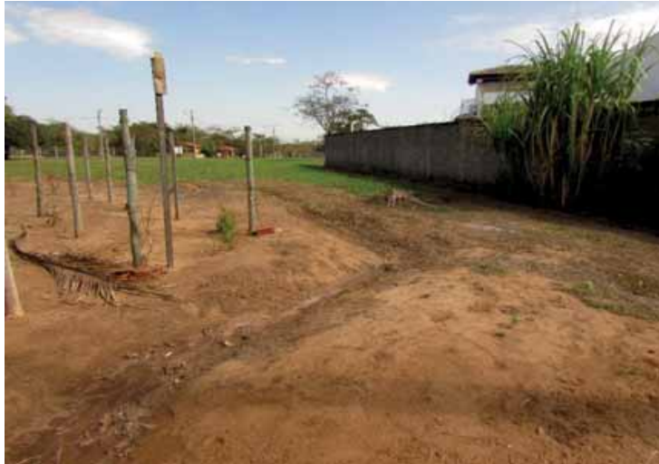
Fotografia 6 – Erosão dentro de um lote na Rua Tupis
