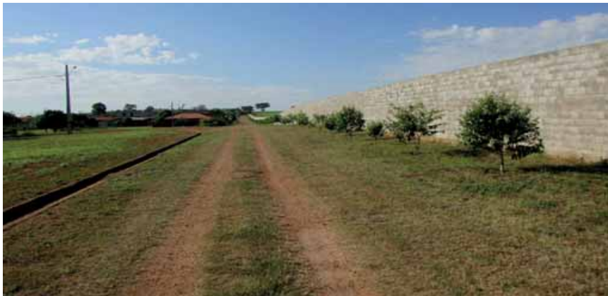
Fotografia 7 – Trechos sem guias e sarjetas na Rua Aimorés (lado dir.)
