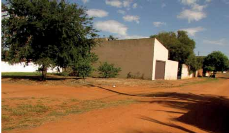
Fotografia 8 – Depressão existente na Rua Tamoios
