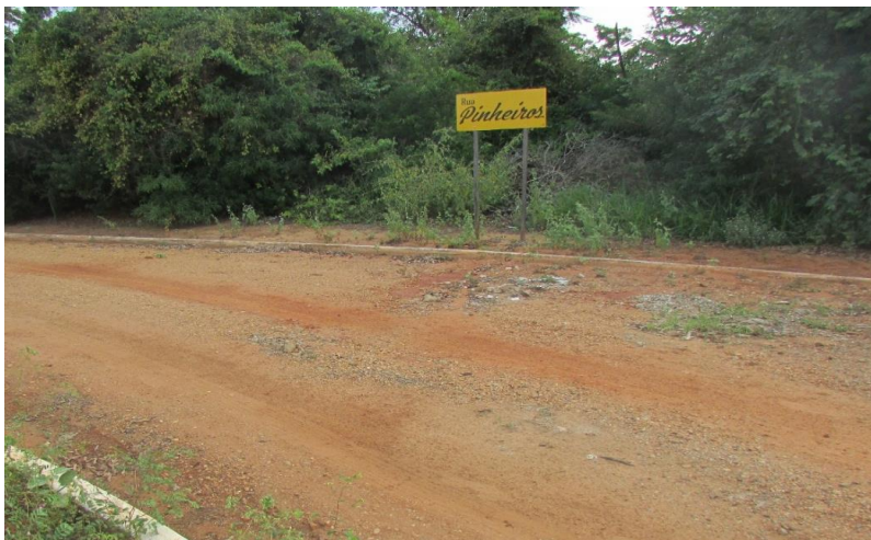
Fotografia 1 – Erosão laminar na Rua Pinheiros e Área Verde
