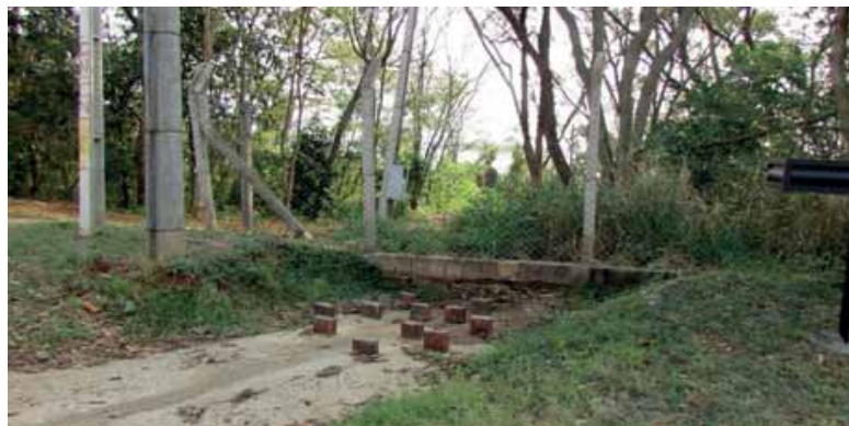
Fotografia 13 – Dissipador de energia de águas pluviais em Área Verde 4 (Quadra 10) no loteamento "Recanto das Águas"
