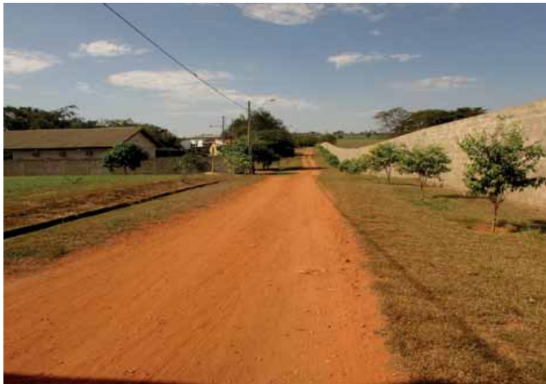
Fotografia 9 – Trechos sem guias e sarjetas na Rua Aimorés (lado dir.)
