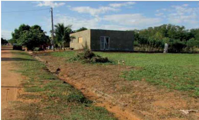
Fotografia 1 – Lotes não demarcados em nenhum terreno e guias e sarjetas quebradas em diversos locais
