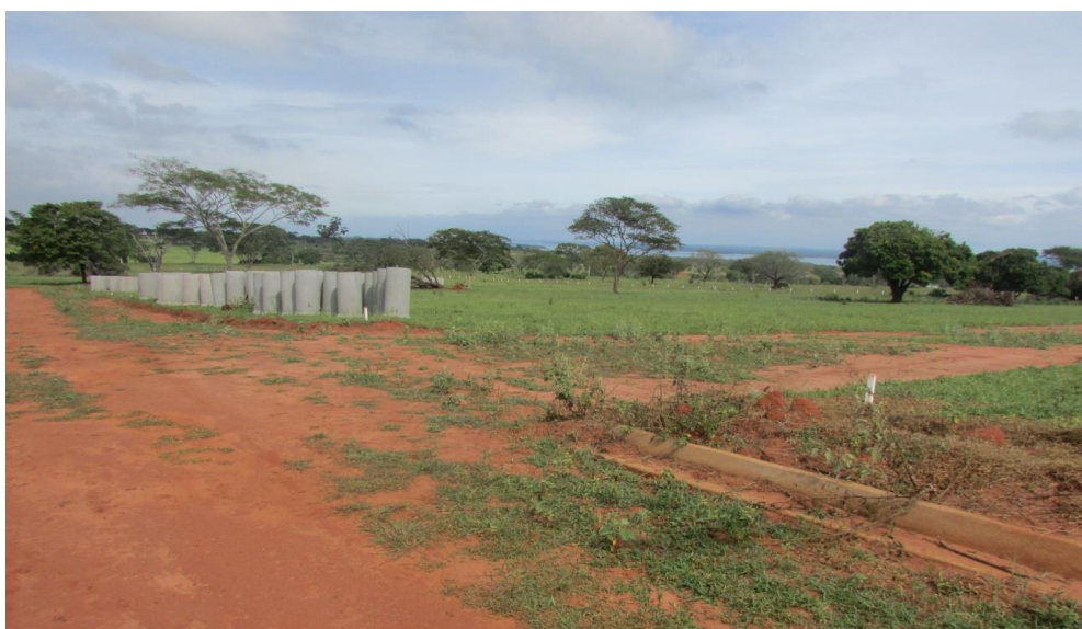
Fotografia 2 – Fim do trecho de guias e sarjetas
