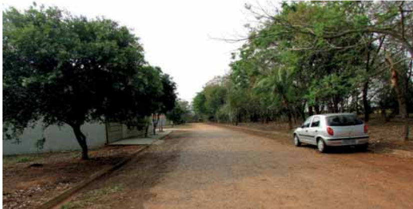
Fotografia 5 – Vias públicas (1) com guias, sarjetas, cascalho, rede de água, energia elétrica, iluminação pública e arborização dos passeios no loteamento “Recanto das Águas”
