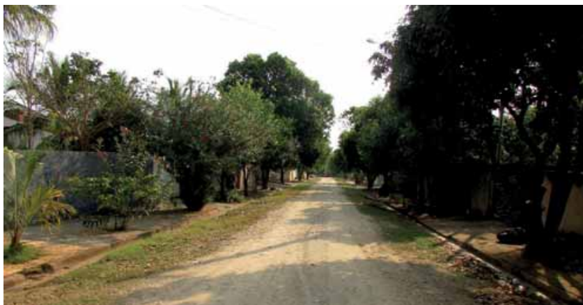
Fotografia 7 – Vias públicas (3) com guias, sarjetas, cascalho, rede de água, energia elétrica, iluminação pública e arborização dos passeios no loteamento “Recanto das Águas”
