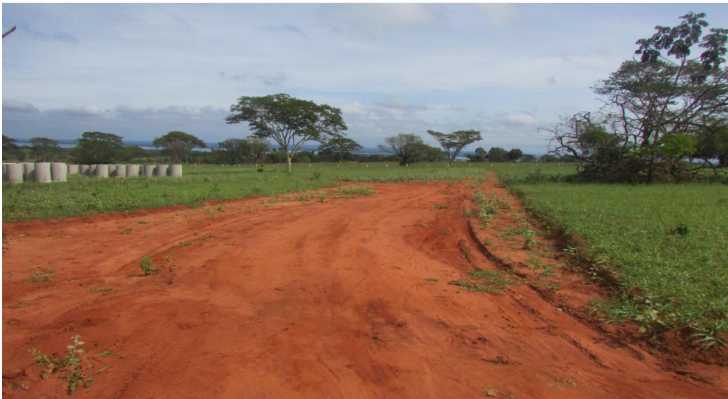
Fotografia 4 – A 2ª Etapa conta apenas com abertura de ruas
