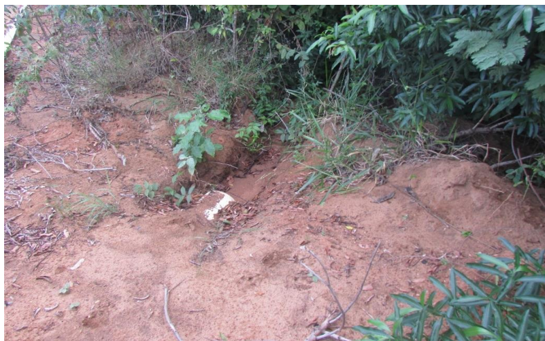
Fotografia 8 – Detalhe da erosão no início da Área Verde (Gleba 1-B)
