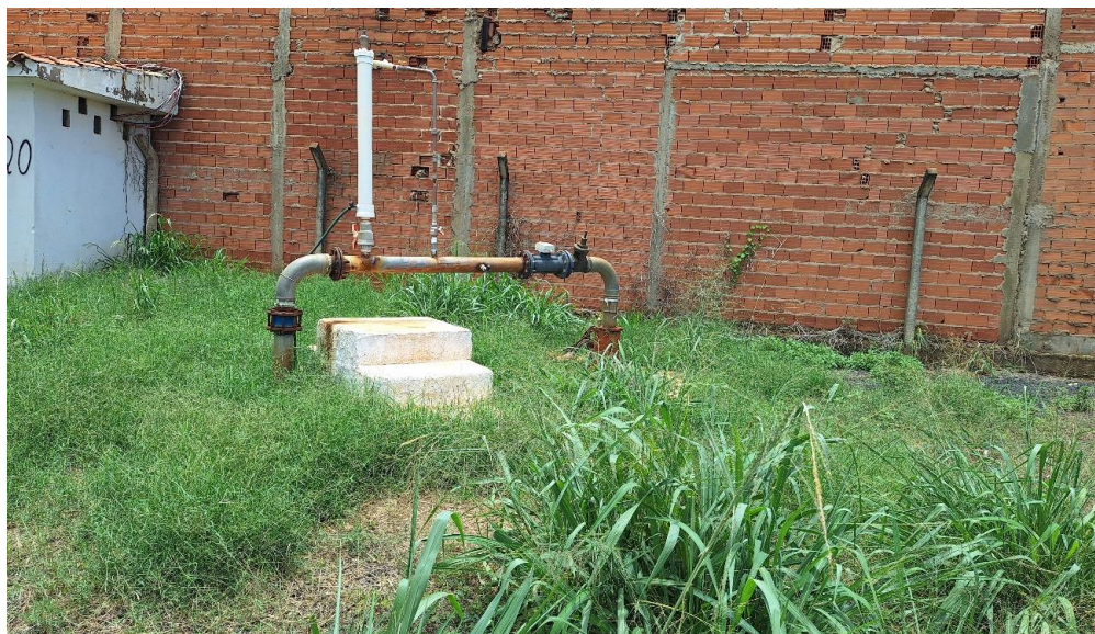
Figura 47: Vista do poço P-20.
