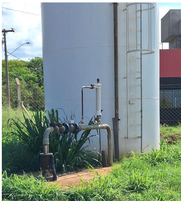
Figura 56: Vista do poço P-26.
