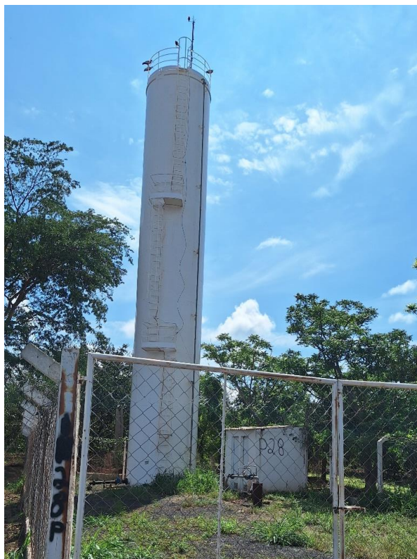
Figura 70: Vista do reservatório R-24.
