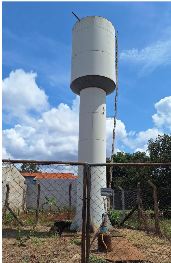
Figura 66: Vista do reservatório R-09.
