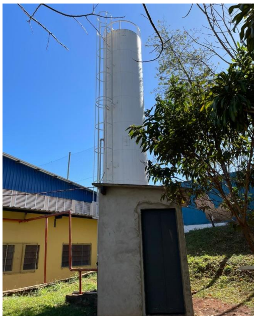
Figura 22: Vista do reservatório R-03.
