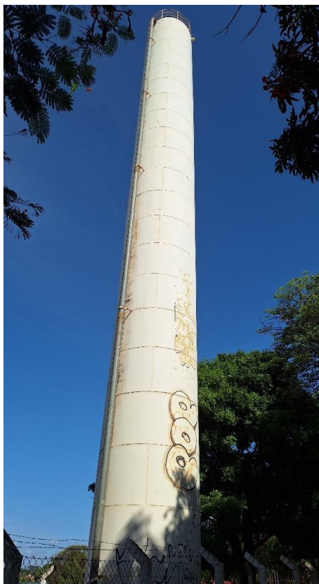
Figura 18: Vista do reservatório R-12.
