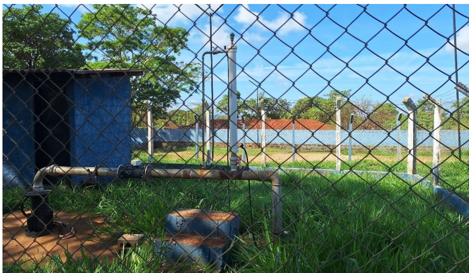
Figura 17: Vista do poço P-03.
