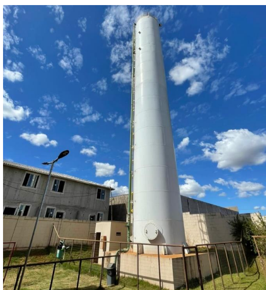
Figura 55: Vista do reservatório São José.
