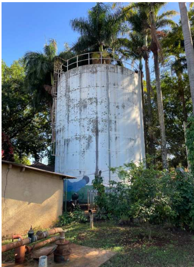
Figura 24: Vista do reservatório R-10 (desativado).
