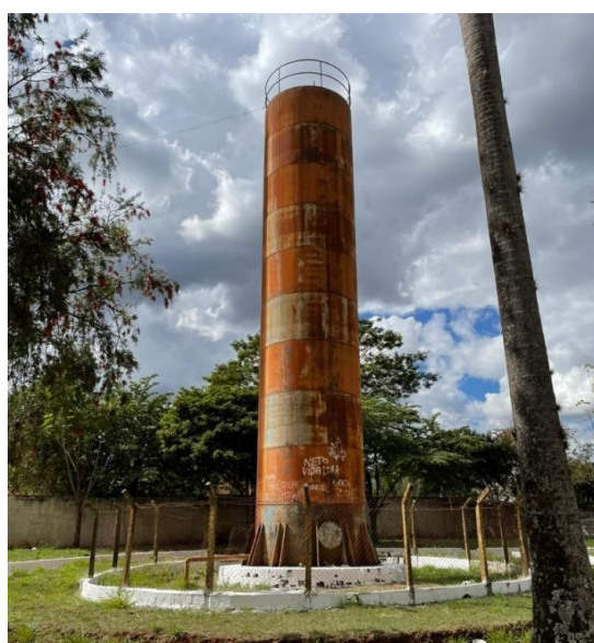
Figura 21: Vista do reservatório R-02.
