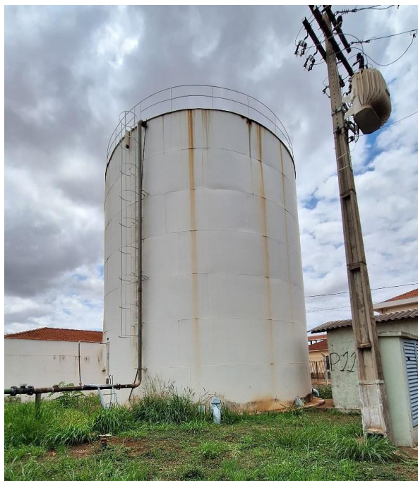
Figura 37: Vista do reservatório R-16.
