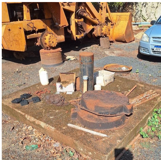
Figura 28 Novo poço aguardando instalação de bomba e infraestrutura elétrica
