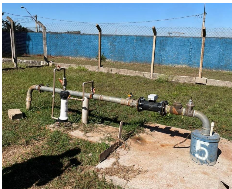
Figura 20: Vista do poço P-05.
