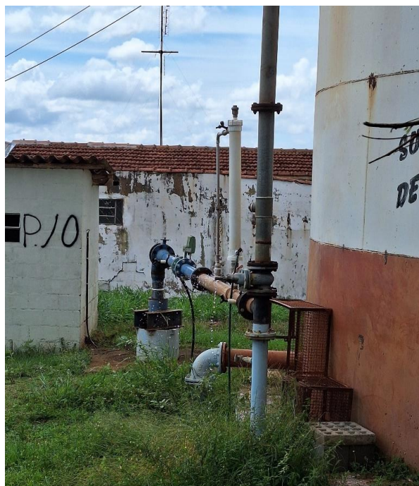
Figura 34: Vista do poço P-10.
