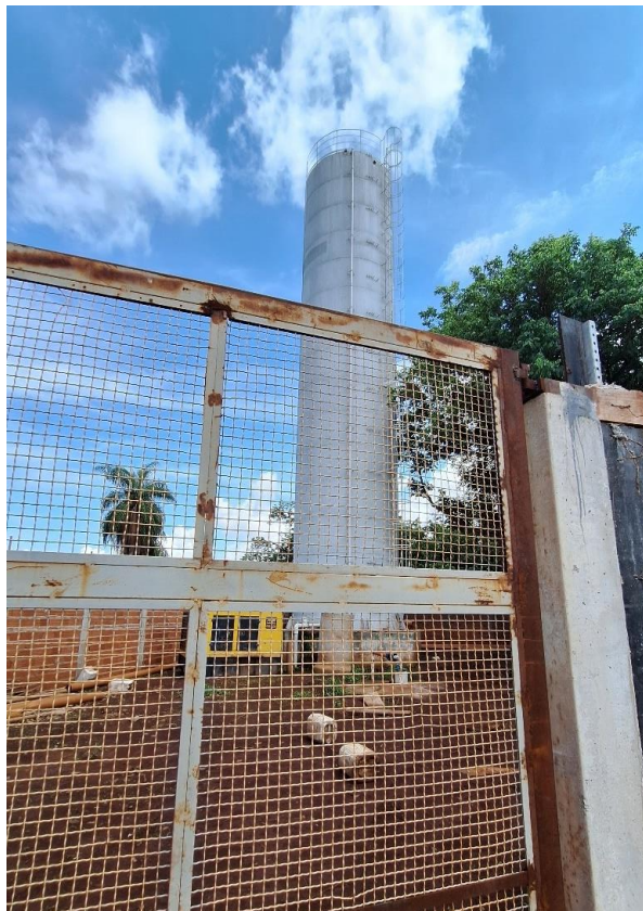
Figura 73: Vista do reservatório Bonela.
