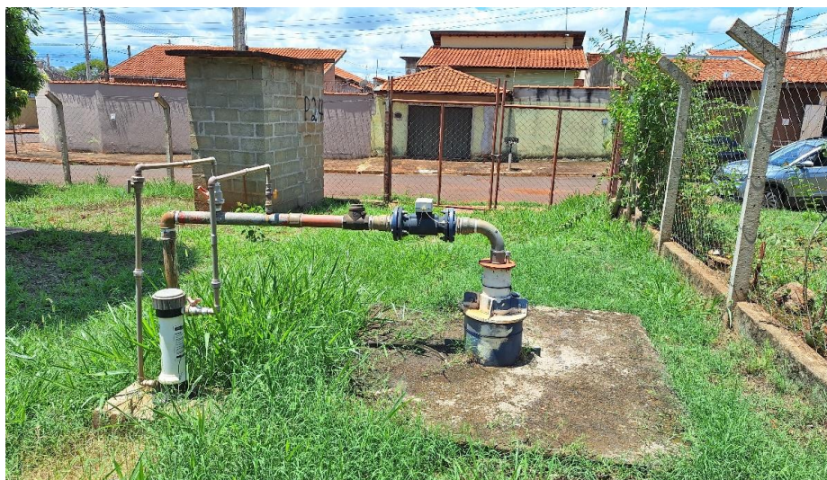
Figura 52: Vista do poço P-24.
