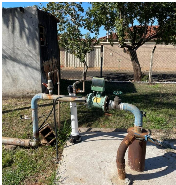
Figura 19: Vista do poço P-04 com equipamento Hidrojet.
