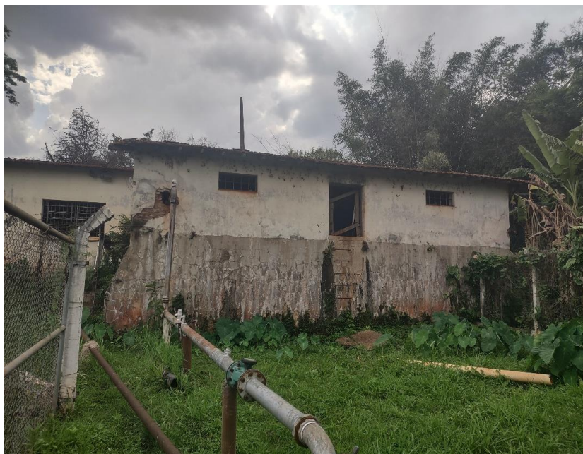
Figura 14: Vista do reservatório R01
