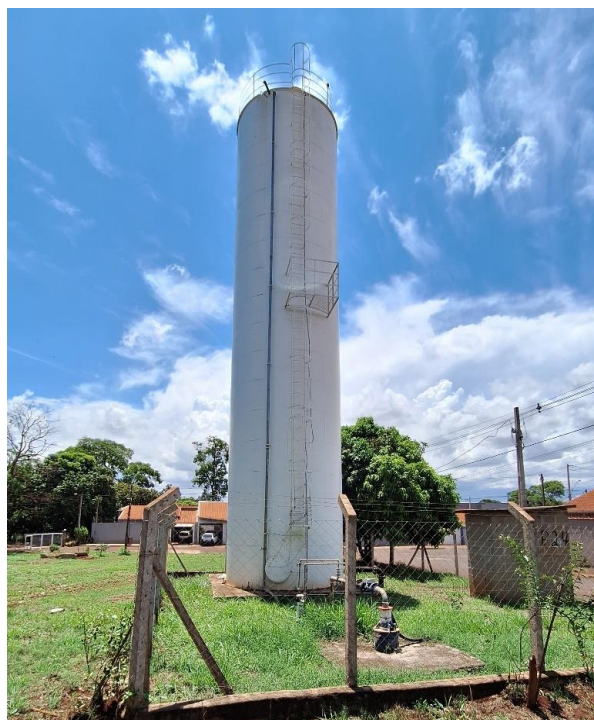
Figura 53: Vista do Reservatório R-22.
