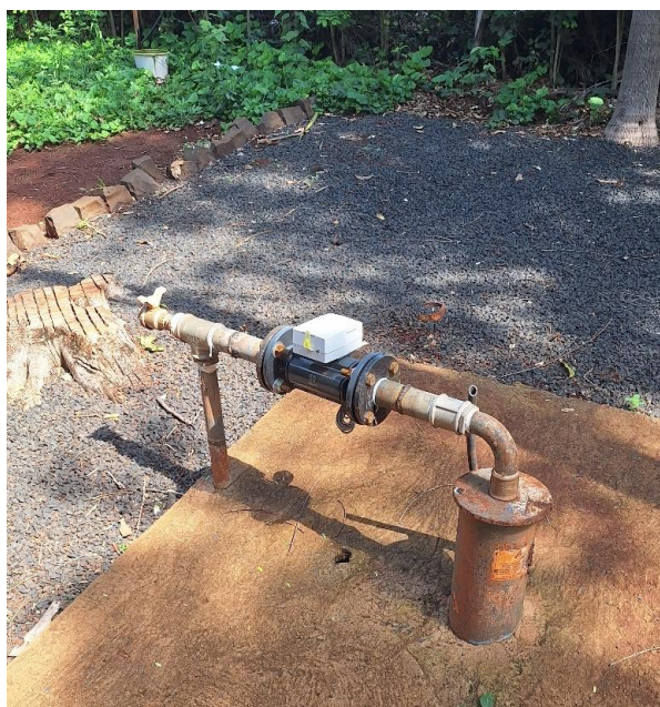
Figura 41: Vista do poço P-15.
