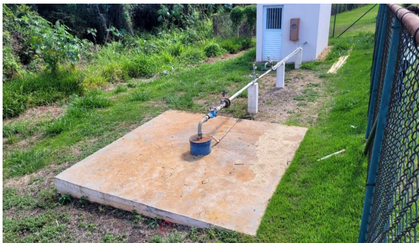
Figura 54: Vista do poço P-25.
