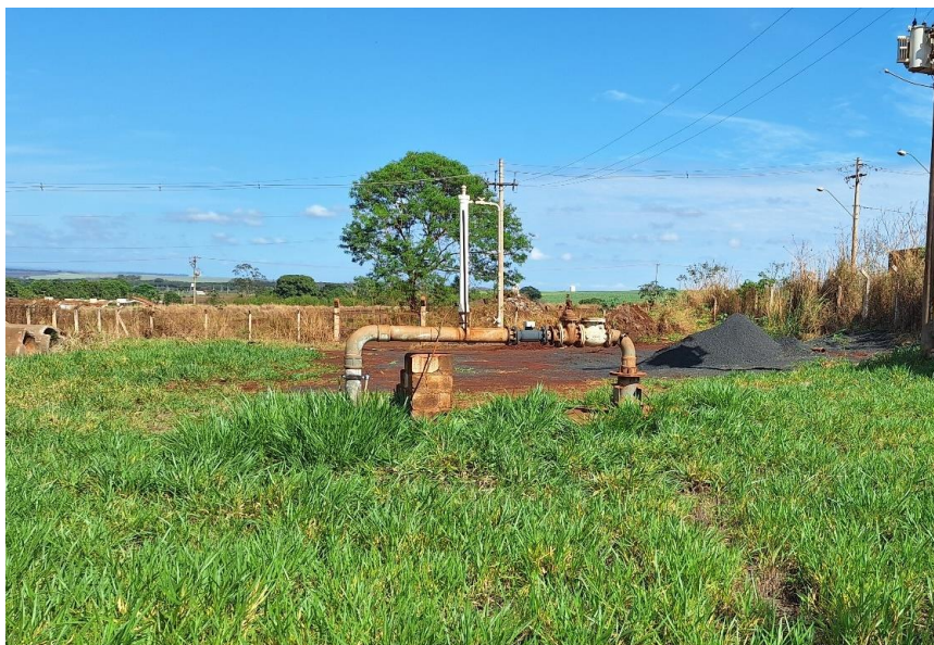
Figura 32: Vista do poço P-09.
