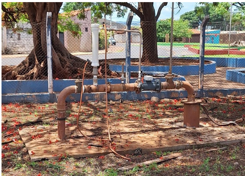
Figura 31: Vista do poço P-08.
