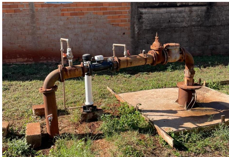
Figura 43: Vista do poço P-16.
