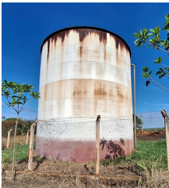
Figura 33: Vista do reservatório R-05.
