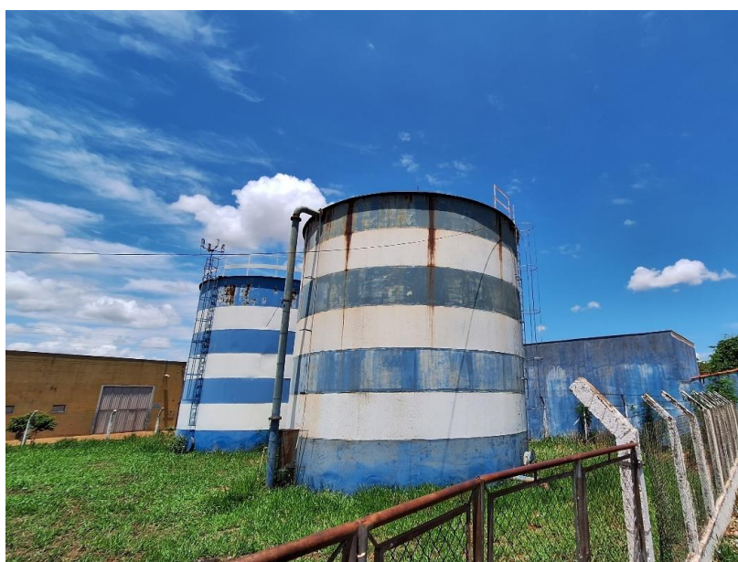
Figura 40: Vista dos reservatórios apoiados que compõem o sistema R-07.
