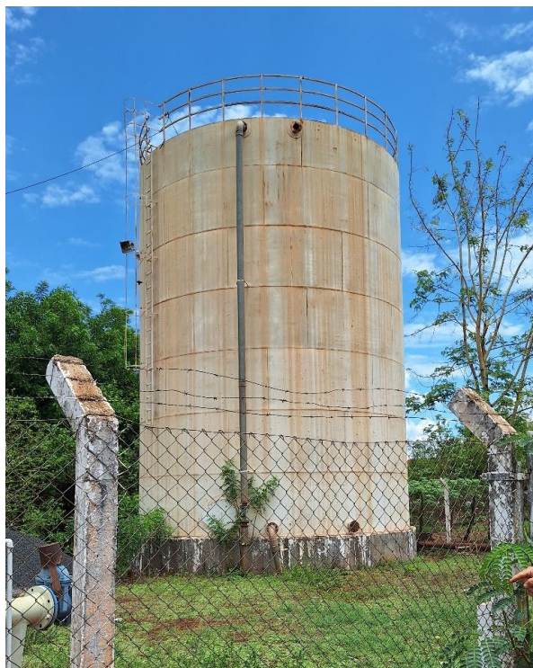
Figura 45: Vista do reservatório R-11.
