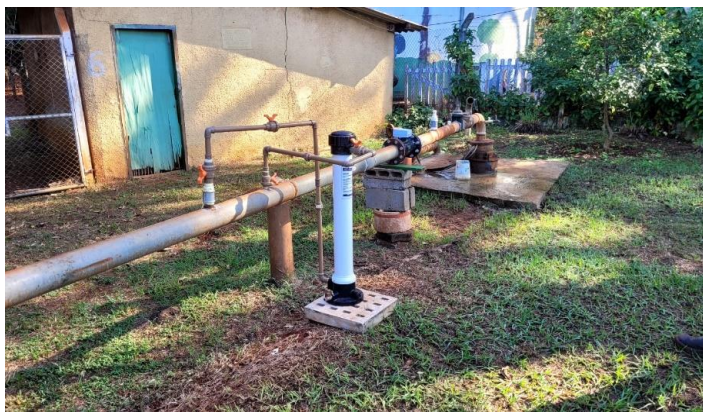
Figura 23: Vista do poço P-06.
