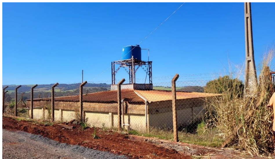
Figura 59 Vista do Reservatório R-15 (desativado).
