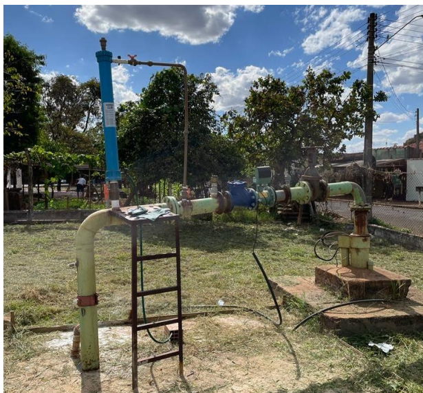
Figura 39: Vista do poço P-13.
