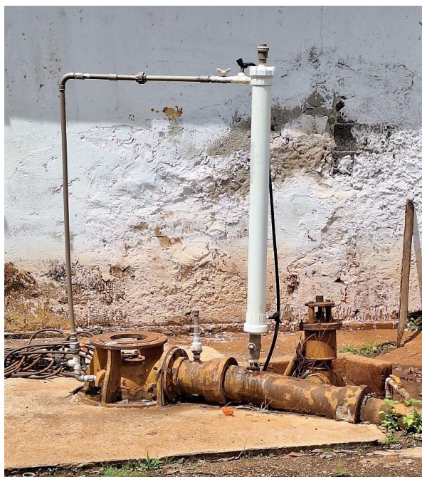
Figura 16: Vista do poço P02
