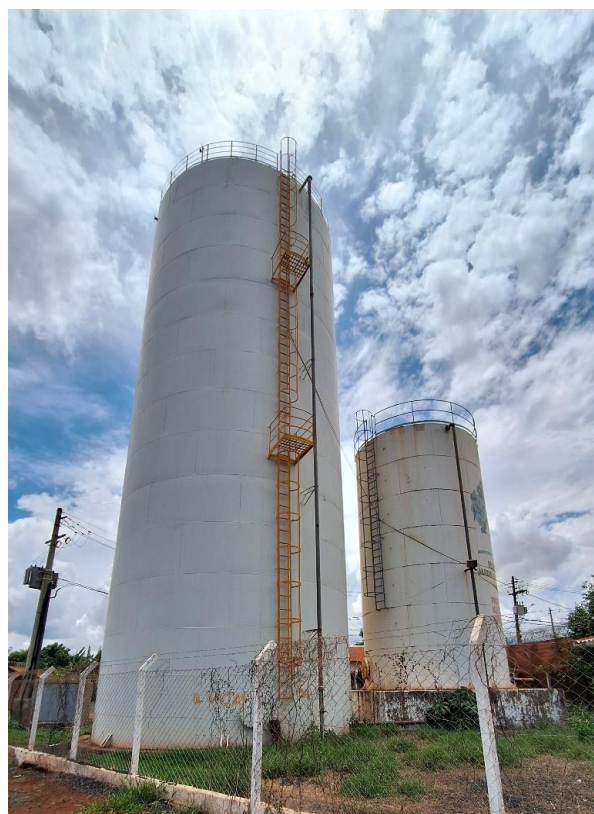
Figura 48: Vista dos reservatórios R-18.
