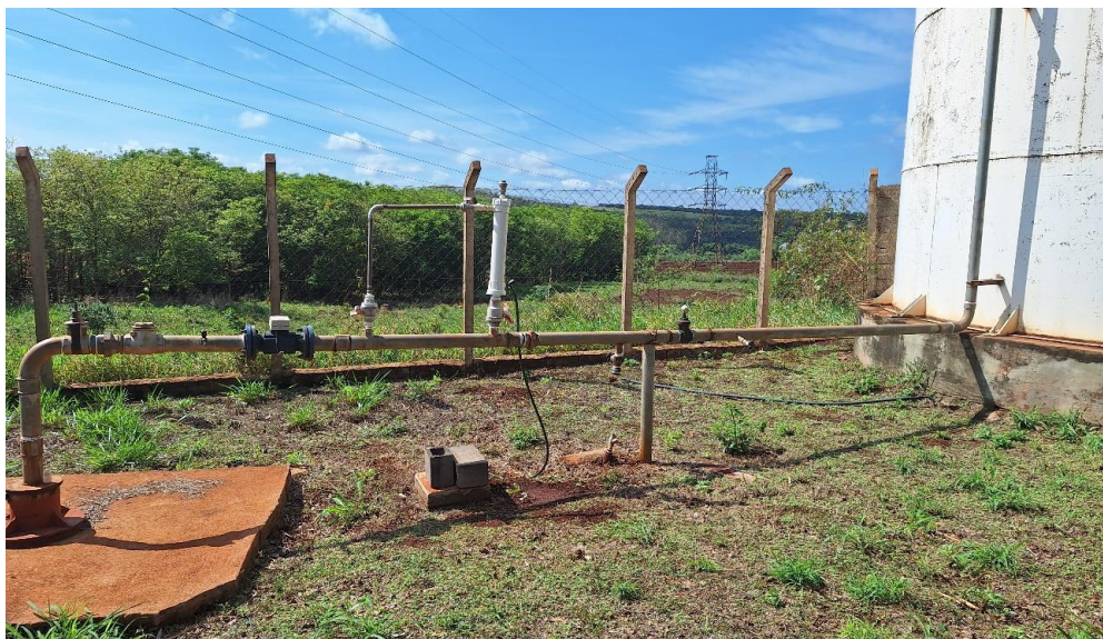
Figura 49: Vista do poço P-21.
