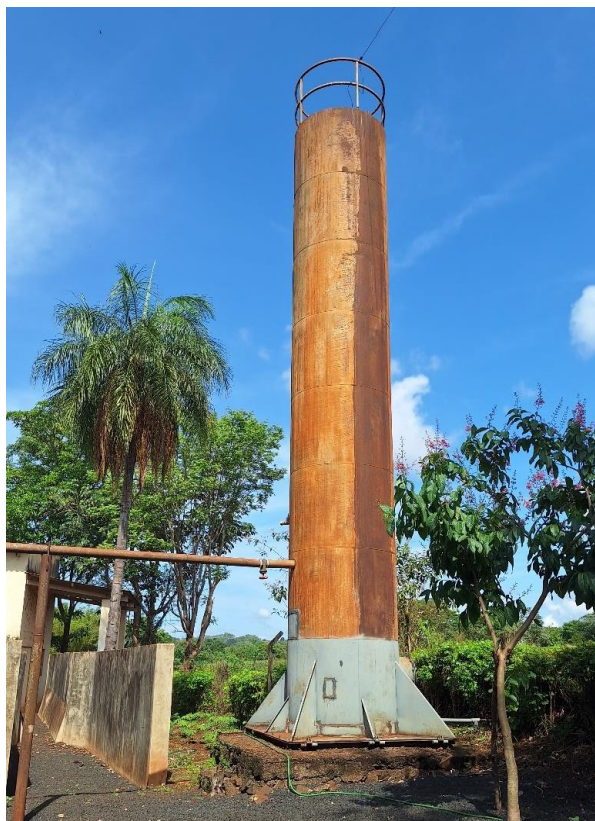
Figura 42: Vista do reservatório R-23.
