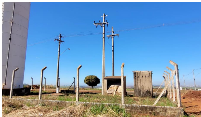
Figura 51: Vista do poço P-23 e reservatório R-19.
