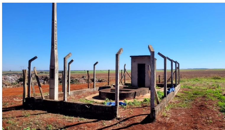
Figura 82 Vista da EEE Industrial.
