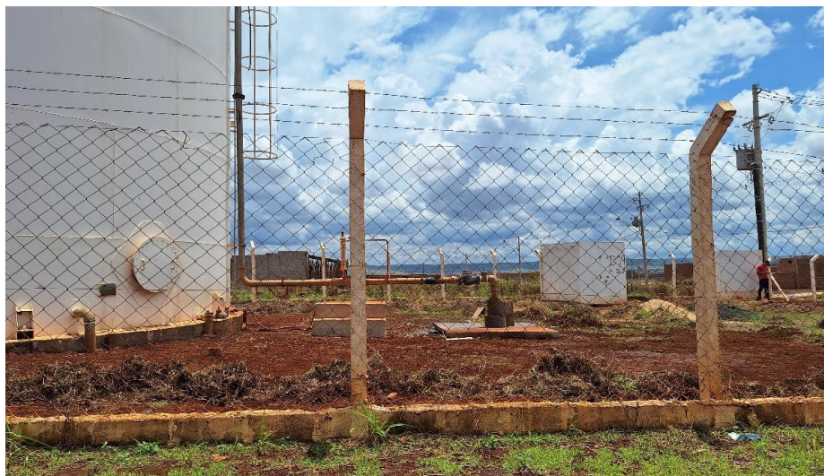
Figura 61 Vista do poço novo Adib Rassi.
