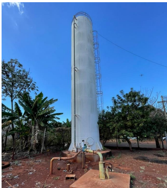
Figura 68: Vista do reservatório R-13.
