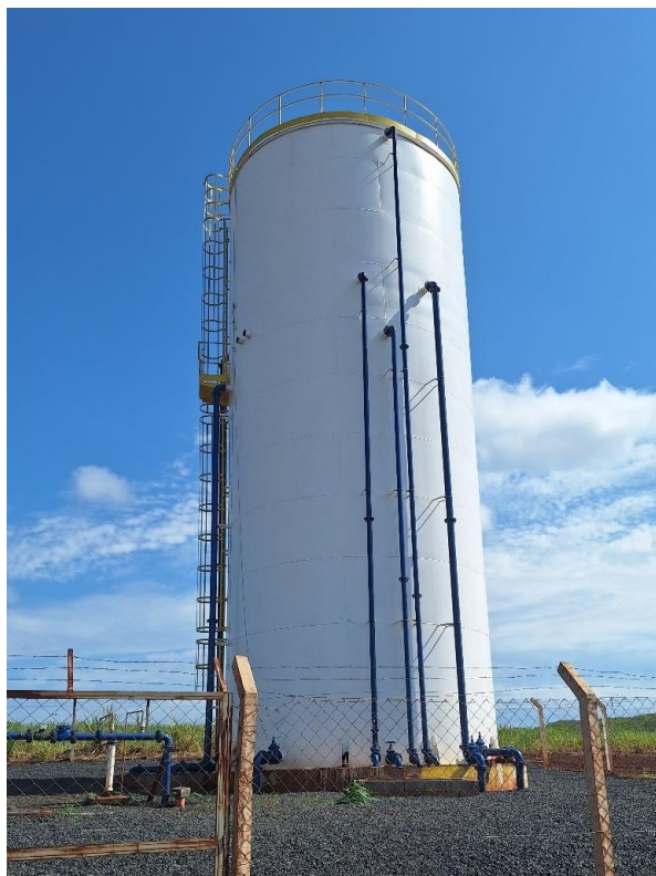
Figura 60 Vista do Reservatório R-15a.
