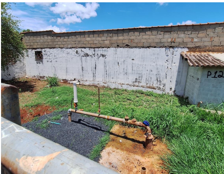
Figura 38: Vista do poço P-12.
