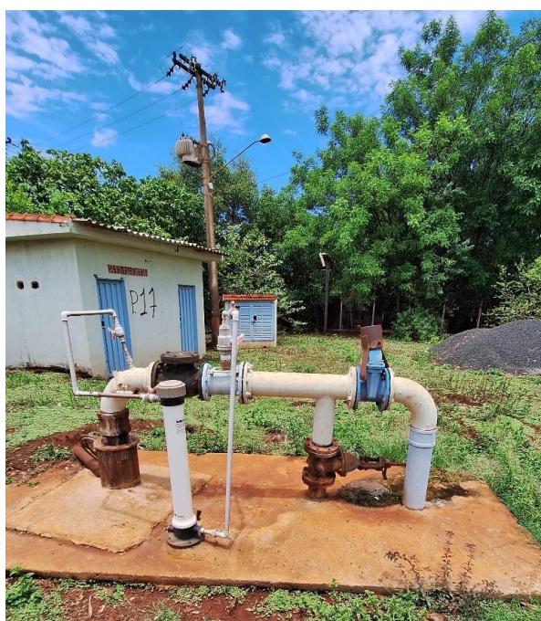
Figura 44: Vista do poço P-17.
