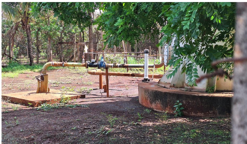
Figura 67: Vista do poço P-19.
