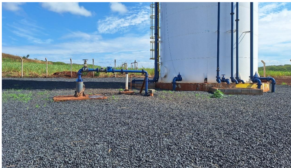
Figura 58 Vista do poço P-27.
