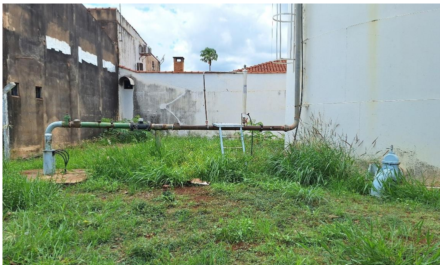
Figura 36: Vista do poço P-11.
