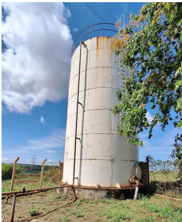
Figura 50: Vista do reservatório R-14.
