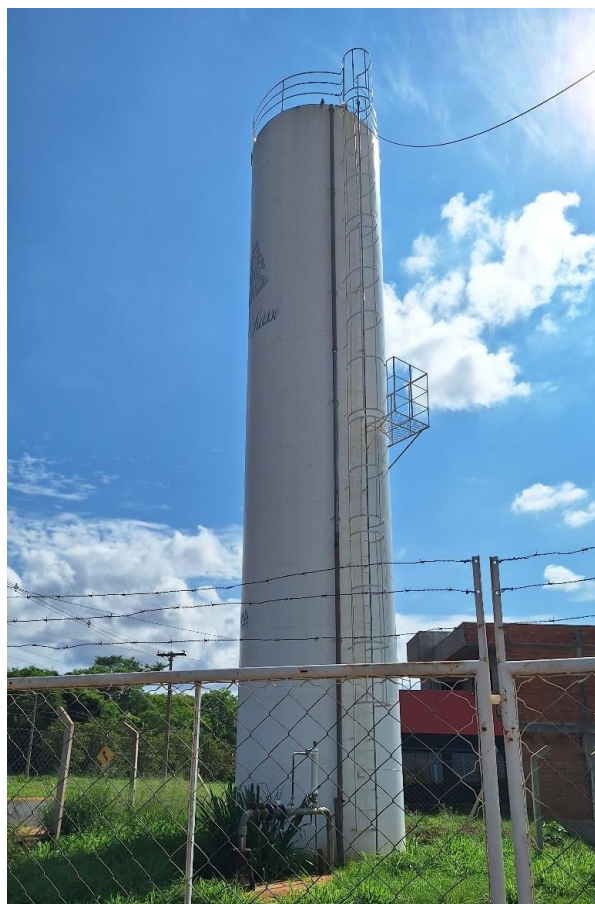
Figura 57: Vista do reservatório R21.
