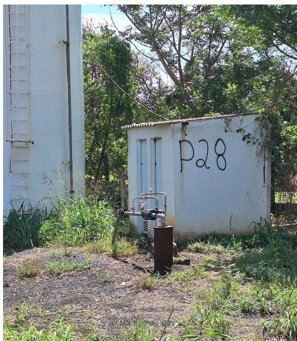
Figura 69: Vista do poço P-28.
