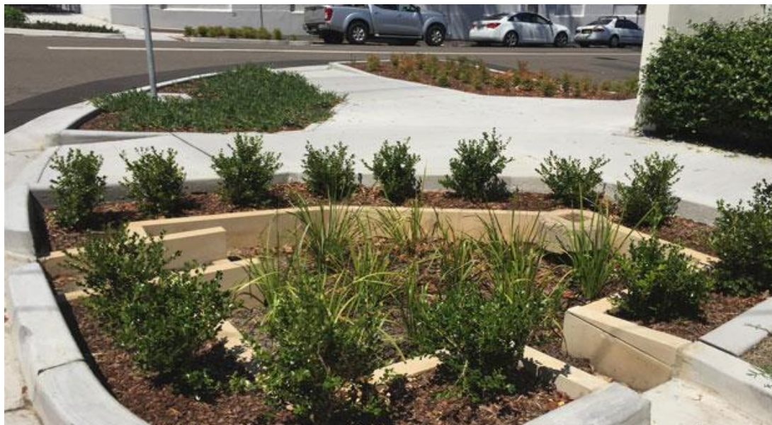
Figura 7 – Exemplo de jardim de chuva instalado
