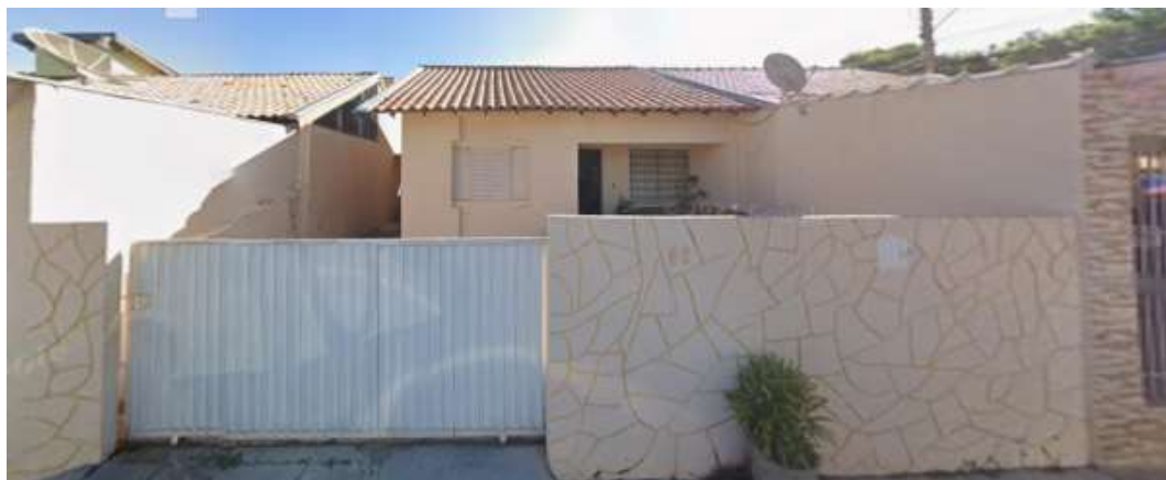
Vista frontal do imóvel.
