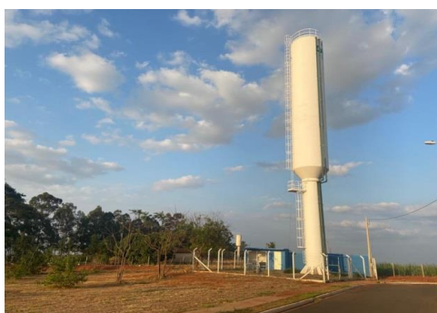
Figura 56: Vista Geral do Reservatório R-56
