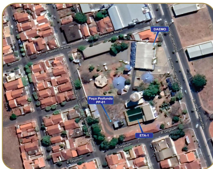
Figura 22: Localização do Poço Profundo PP-01
