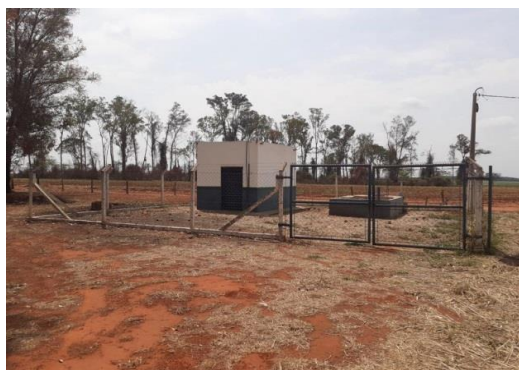
Figura 64: Vista geral da área externa da EEE do Jardim Colorado
