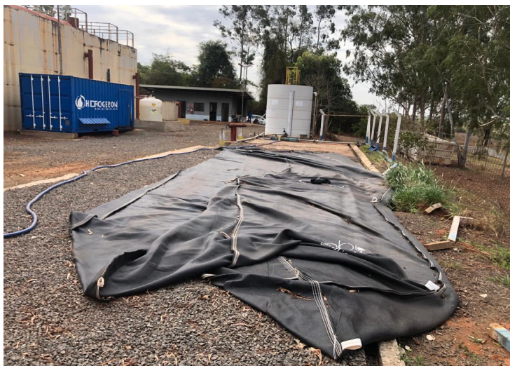
Figura 82: Vista do Geobag utilizado para desaguamento de lodo resultante da ECTE Córrego dos Pretos
