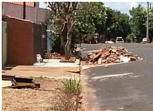
Figura 102: Pilha de RCC disposta em via pública
