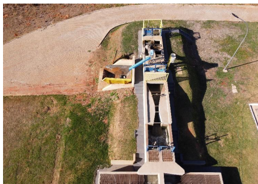
Figura 84: Sistema de Entrada de esgoto – Tratamento Preliminar
