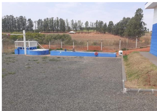
Figura 66: Vista geral da área da ETE do Jardim Botânico
