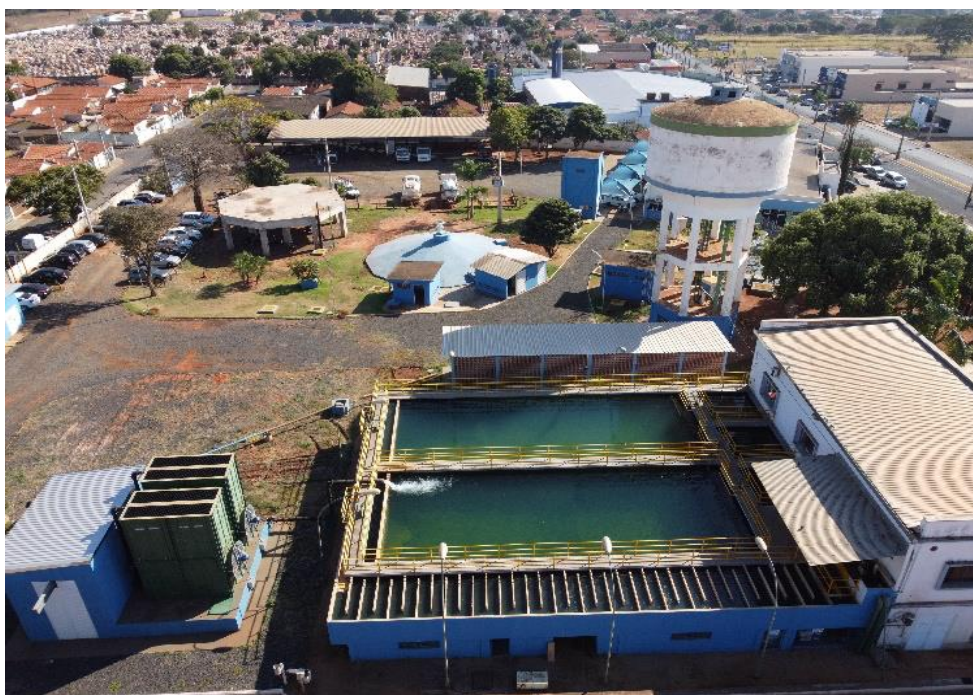
Figura 32: Vista aérea dos módulos de tratamento da ETA-1
