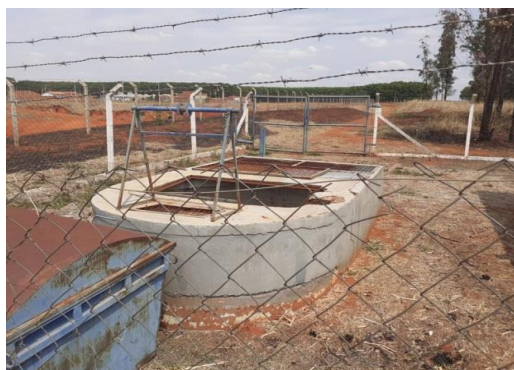
Figura 65: Detalhe da estrutura da EEE do Jardim Colorado
