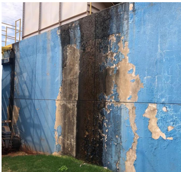
Figura 52: Situação atual do Reservatório Elevado da ETA-2
