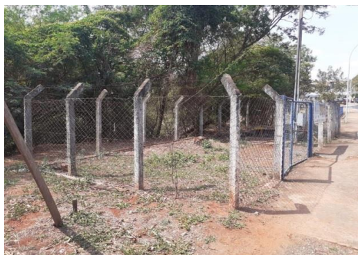
Figura 60: Vista geral da área externa da EEE do Tropical
