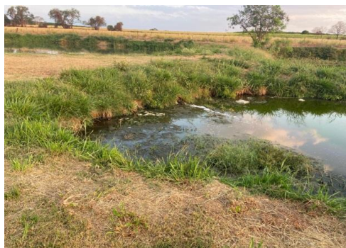
Figura 99: Vista das margens das lagoas da ETE Ribeiro dos Santos
