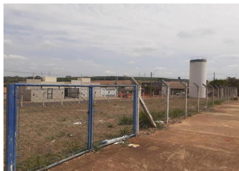
Figura 55: Vista Geral do Reservatório R-44
