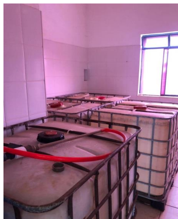
Figura 37: Depósito de produtos químicos da ETA-1
