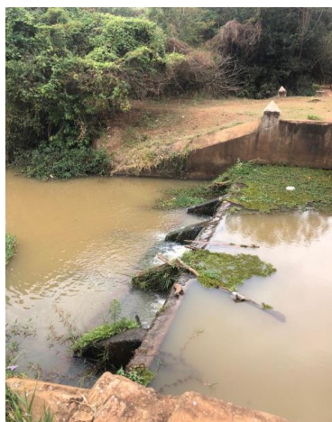
Figura 18: Vista da barragem de nível no Ribeirão Olhos D'Água
