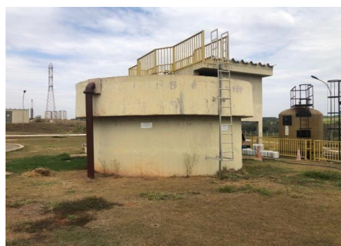
Figura 93: Adensador de Lodo e Casa de Desidratação do lodo, ao fundo
