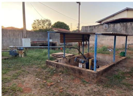
Figura 63: Vista da estrutura física e das instalações da EEE do Alvorada
