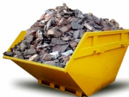
Figura 103: RCC acondicionado em caçamba estacionária
