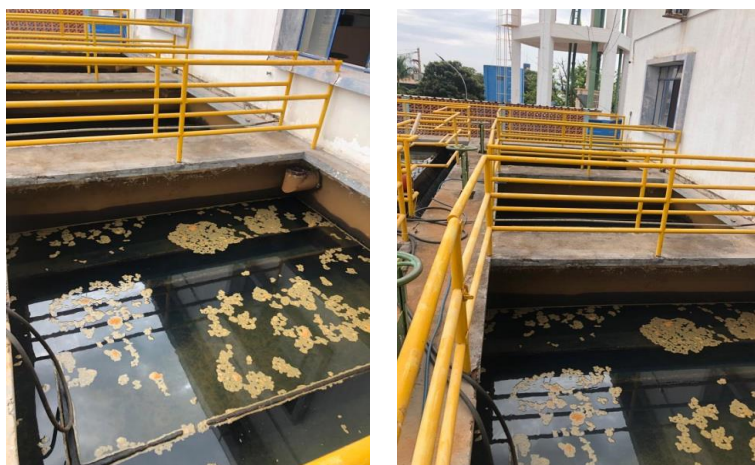
Figura 34: Detalhe dos Filtros da ETA-1
