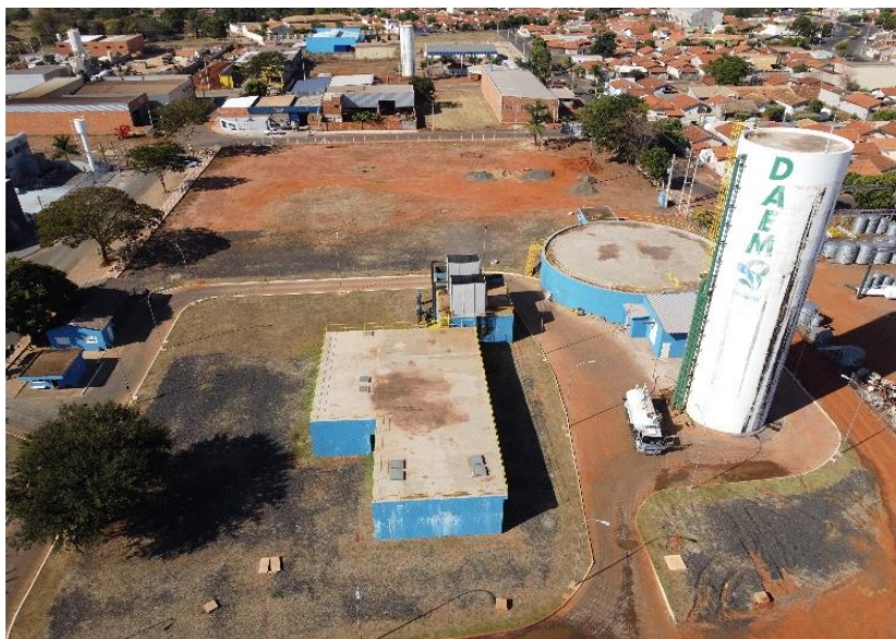
Figura 42: Vista geral da planta de tratamento da ETA-2
