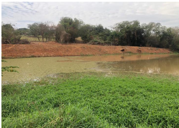
Figura 15: Vista do Ribeirão Olhos D'Água nas proximidades do ponto de captação
