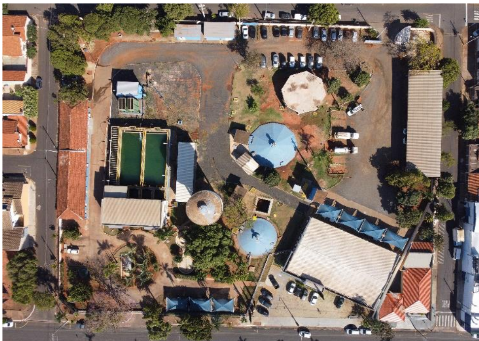
Figura 31: Vista aérea da ETA-1
