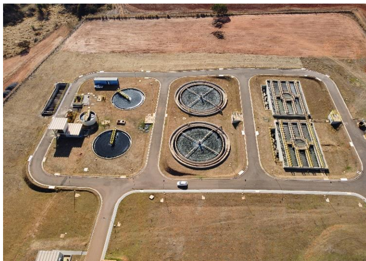
Figura 83: Vista geral da ETE Olhos D'Água
