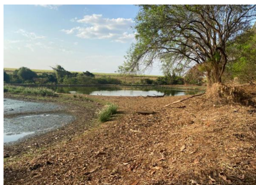
Figura 97: Estado de Conservação das margens das lagoas da ETE Bagaçu
