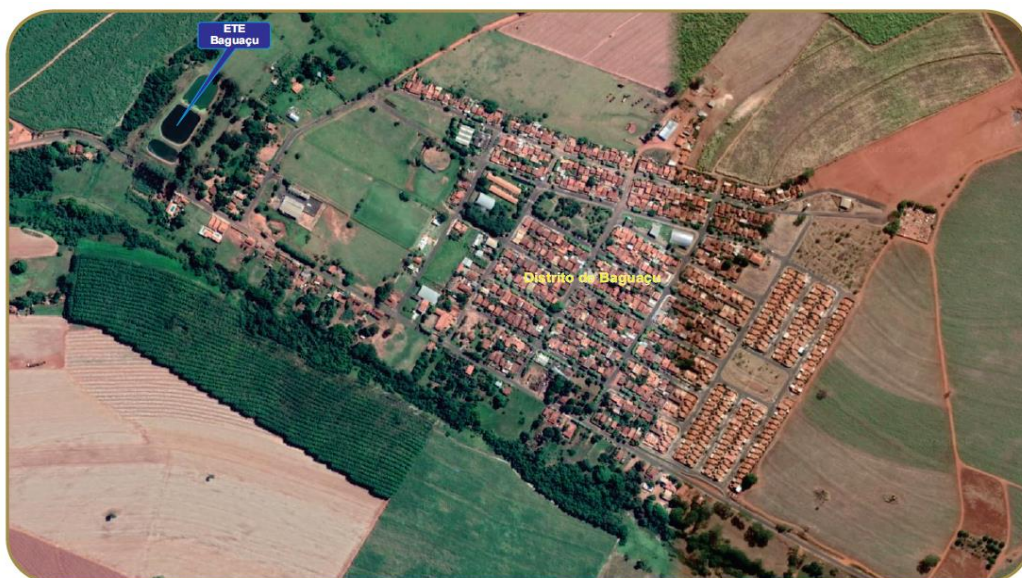
Figura 75: Localização da Estação de Tratamento de Esgoto do Distrito de Baguaçu
