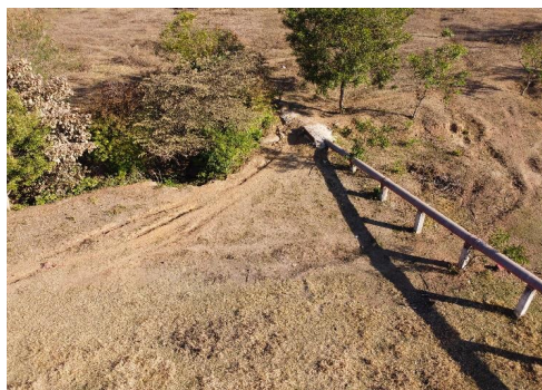
Figura 80: Linha de recalque de efluente tratado
