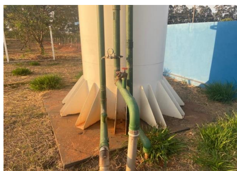
Figura 57: Detalhe do Reservatório R-56
