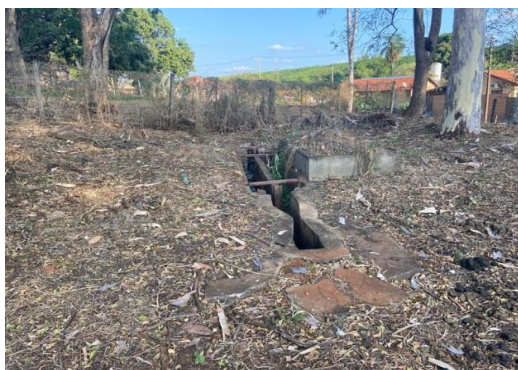
Figura 96: Vista da estrutura do sistema de entrada da ETE Bagaçu
