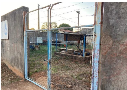
Figura 62: Vista geral da área externa da EEE do Alvorada
