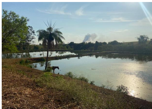
Figura 94: Vista geral das lagoas da ETE Bagaçu
