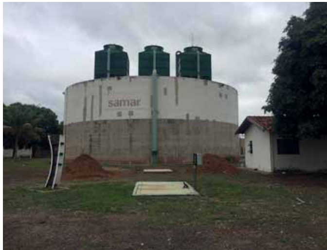
Figura 23 – Reservatório do Jussara.
