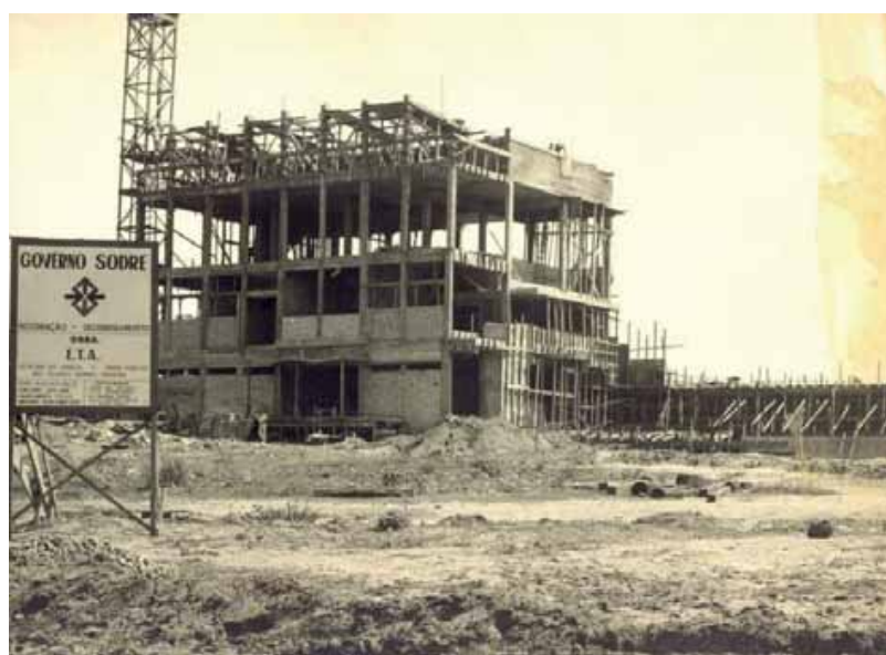
Figura 19 – Estação de Tratamento de Água
