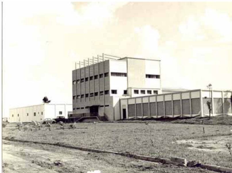
Figura 20 – Estação de Tratamento de Água
