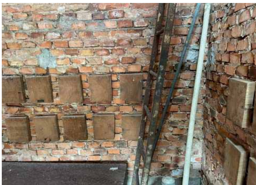
Mais detalhes de como ficavam as vigas de sustentação dos sinos em madeira, fixadas nas paredes que foram substituídos, pela segurança, por vergalhões metálicos
