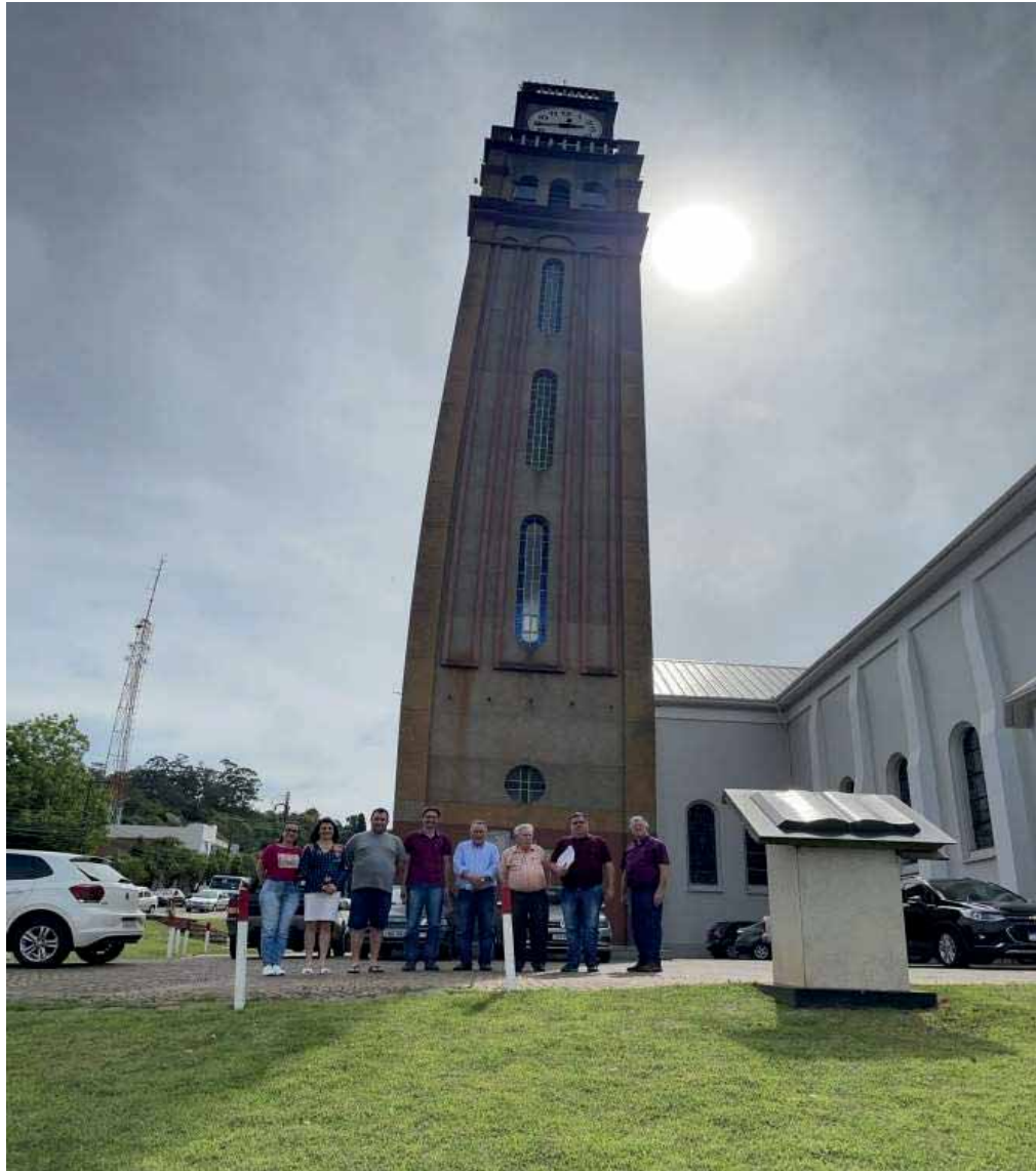
Vista Externa da Torre e Comissão de Tombamento
