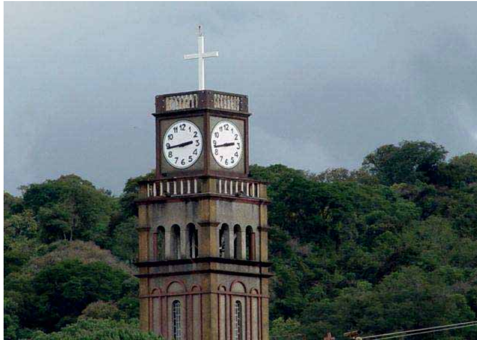
Vista externa da cobertura e detalhe da cruz
