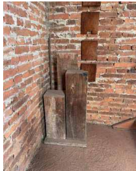
Mais vigas de sustentação dos sinos e detalhe de como ficavam na parede
