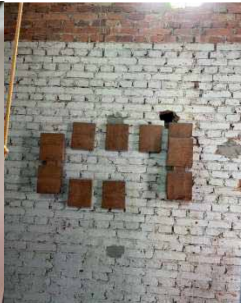
Corte das vigas que antigamente sustentavam os sinos
