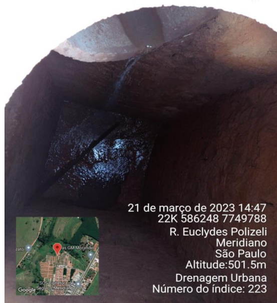
Figura 4: Abertura de buraco no concreto do fundo do Poço de Visita;
