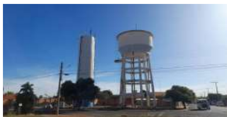
Figura 206 - Caixa d'água do centro de Buritama
