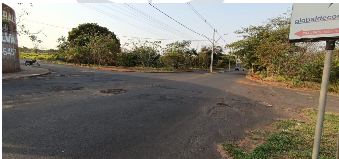
Vista Avenida Frederico Buque Fritz. Fonte: acervo próprio, fotografia tirada em 24/08/2023.
