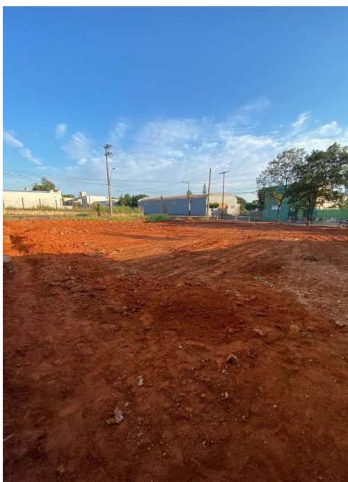
Registro fotográfico do terreno para construção do empreendimento
